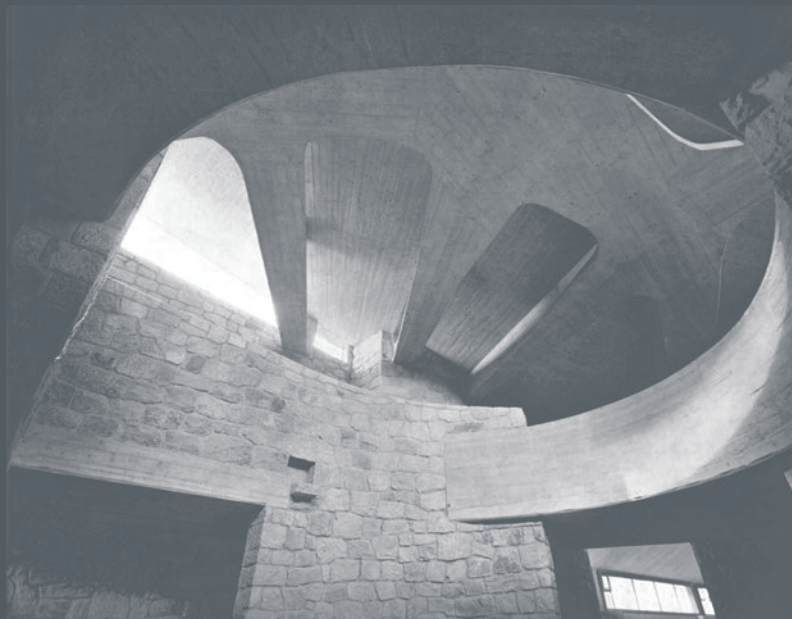
Giovanni Michelucci, chiesa dell'autostrada del Sole, 1964. Trave di copertura del battistero | Baptisery roofing beam. Ph. Gaio Bacci. In G. Michelucci, F. Cova, La Chiesa dell'autostrada del sole S. Giovanni Battista a Campi Bisenzio , Firema, Roma 1964, p. 33.
