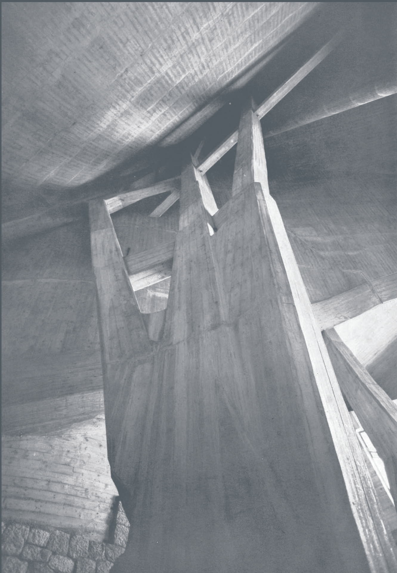
Giovanni Michelucci, chiesa dell'autostrada del Sole, 1964. Le strutture in cemento armato dell'Aula sacra | Reinforced concrete structure of the Chancel. Ph. Gaio Bacci. In G. Michelucci, F. Cova, La Chiesa dell'autostrada del sole S. Giovanni Battista a Campi Bisenzio , Firema, Roma 1964, p. 66.
