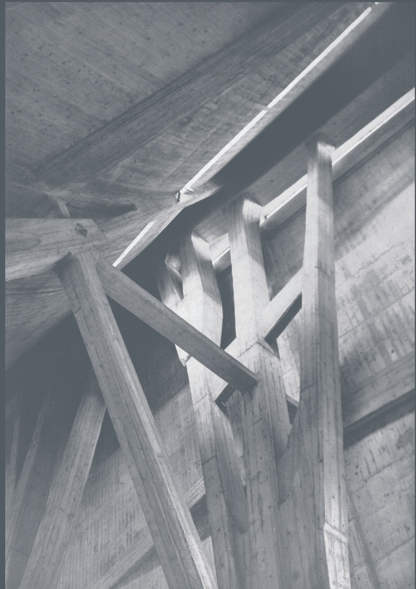
Giovanni Michelucci, chiesa dell'autostrada del Sole, 1964. Le strutture in cemento armato dell'Aula sacra | Reinforced concrete structure of the Chancel. Ph. Gaio Bacci. In G. Michelucci, F. Cova, La Chiesa dell'autostrada del sole S. Giovanni Battista a Campi Bisenzio , Firema, Roma 1964, p. 64.
