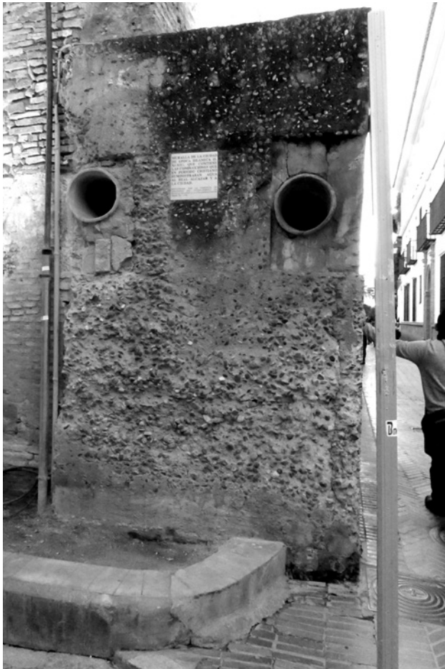
Fig. 9 – Siviglia, resti di tubature fittili dell'antico acquedotto dei Caños de Carmona nel muro di cinta dei Reales Alcazares (foto dell'autore).
