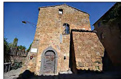
Prospetto esterno sud-ovest
