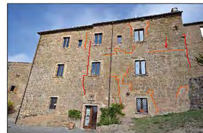
CF9, 8 - Prospetto esterno sud
