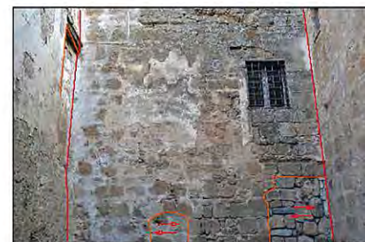
CF9, 8 - Prospetto esterno sud-est
