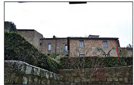
Prospetto esterno sud
