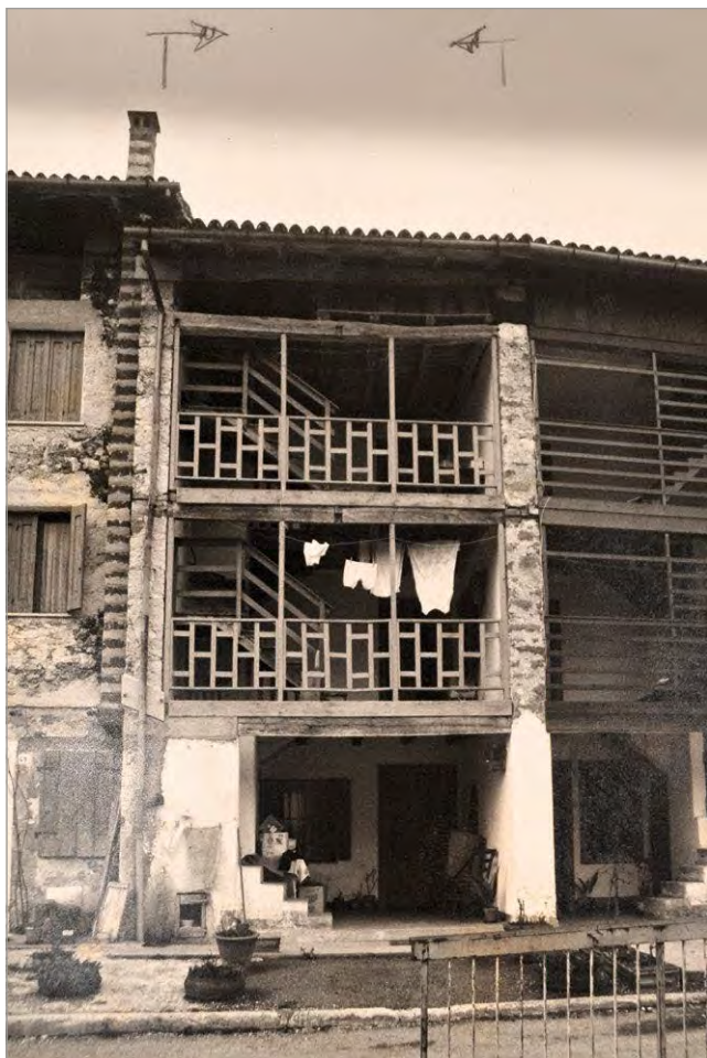
fig. 9 – Andreis (PN), caso studio 4. Fotografia anni '80 prima degli interventi di ripristino del Dalt (Archivio del Comune di Andreis, PN).
