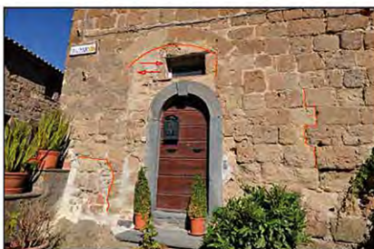
CF10 - Prospetto esterno sud
