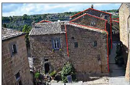
Prospetto esterno sud
