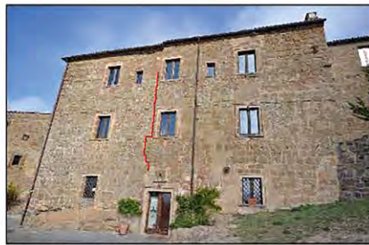
Prospetto esterno sud
