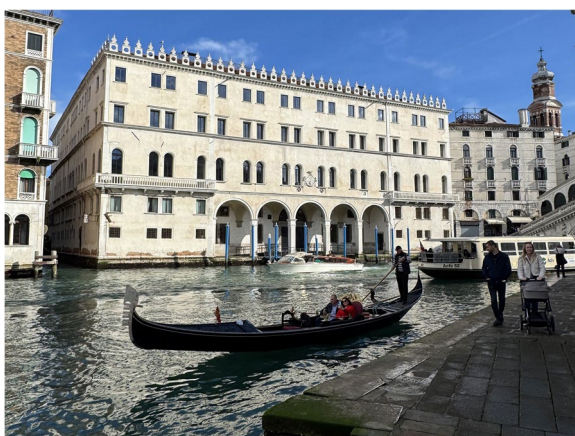
Fig. 4 The Fondaco dei Tedeschi building (Source: the author 2025)
