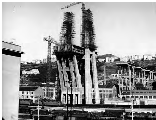
Fig. 5. R. Morandi, la costruzione di una delle pile d'appoggio di un sistema bilanciato (Archivio Centrale dello Stato, fondo Morandi).
