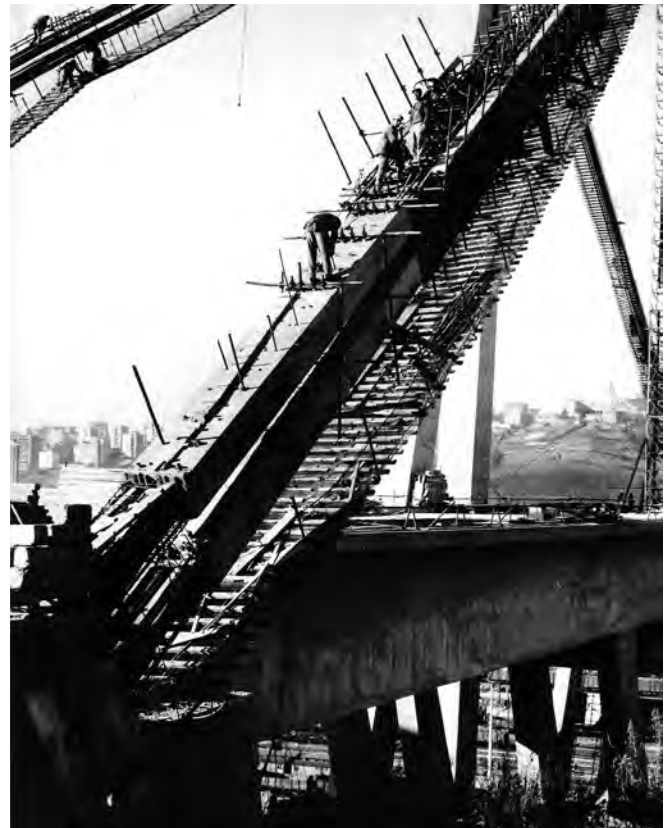
Fig. 10. R. Morandi, il getto delle guaine in cemento armato pre-compresso intorno ai tiranti (Archivio Centrale dello Stato, fondo Morandi).
