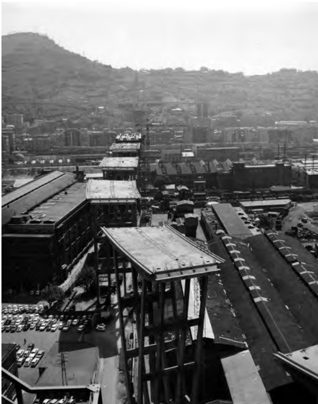
Fig. 9. R. Morandi, una serie di pile di appoggio delle campate di luce minore (Archivio Centrale dello Stato, fondo Morandi).
