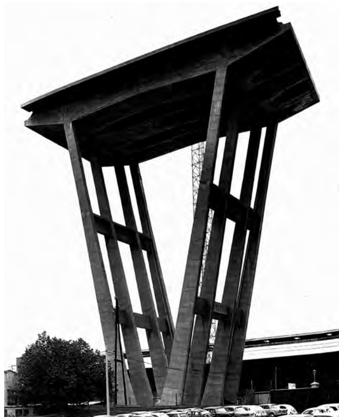
Fig. 4. R. Morandi, una delle pile delle luci minori completata (Archivio Centrale dello Stato, fondo Morandi).
