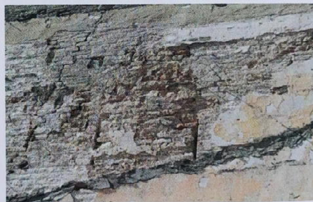
Fig. 14- Finestra ad arco bardellonato ricavata in rottura nell'ogiva della porta urbica e nel relativo tamponamento
