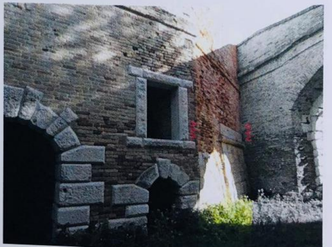
Fig. 8- dettaglio dell'appoggio delle strutture sanmicheliane alla torre del Castel Novo, visibile al centro
