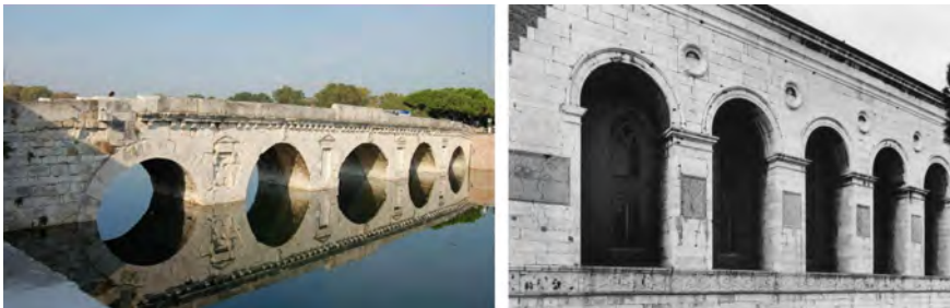
Confronto tra il passo delle arcate del Ponte di Tiberio e quello delle fiancate laterali del Tempio.
