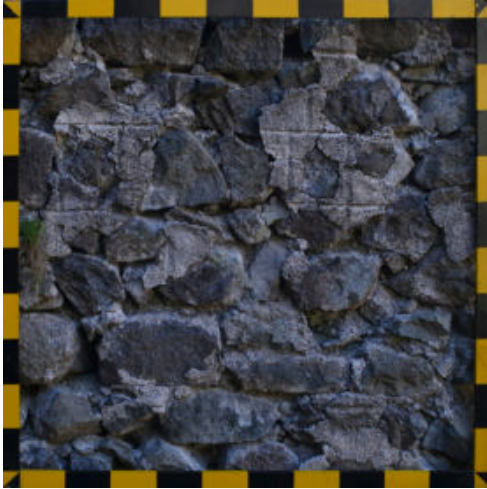
Fig. 8- Paramento murario del palazzo con finitura superficiale dei giunti a lisciatura a scivolo o “falsa cortina incisa” (foto di Isabella Zamboni)
