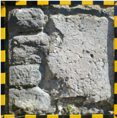
Fig. 9- Torre superiore di XII secolo: angolata in conci squadrate e bugnate (foto di Isabella Zamboni)
