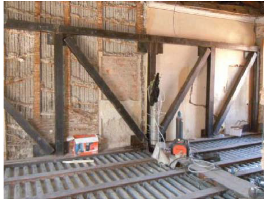
Fig. 19 Installazione di barre NSM.
