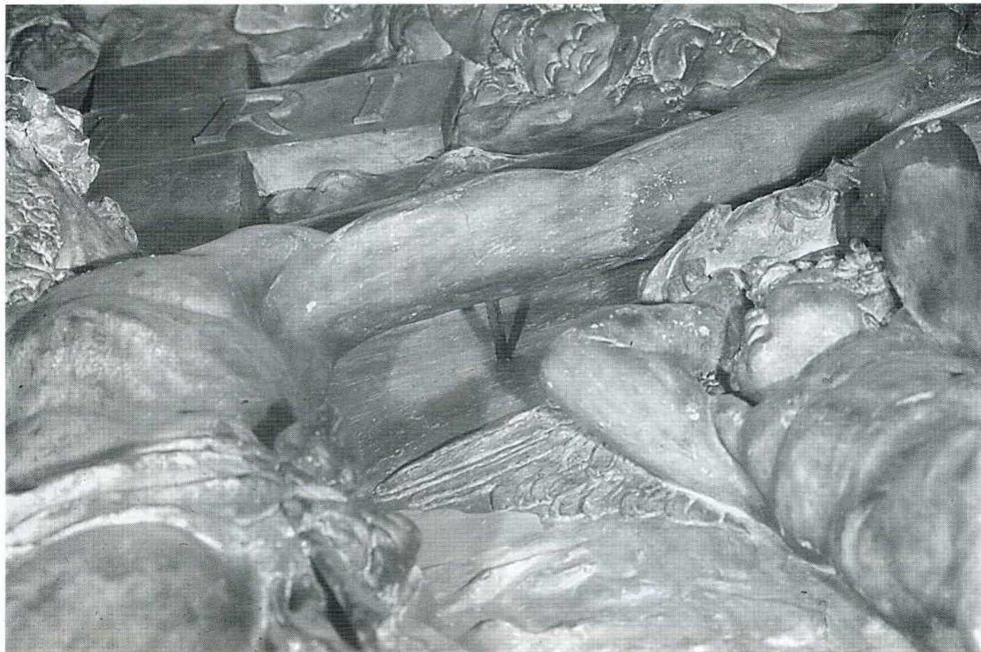
FIG. 11 Particolare di un chiodo di collegamento tra le parti in aggetto antropomorfe e la superficie muraria.
