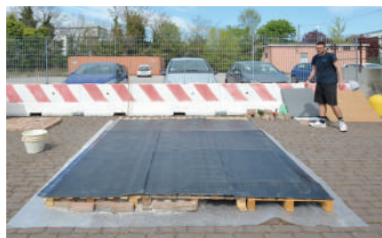
Fig. 3 – L'impalcato è impermeabilizzato da una membrana in bitume polimero
