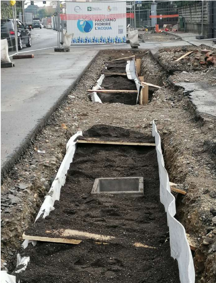
Fig. 2 – Cantiere di via Matteotti in Bovisio Masciago: dettaglio scavi di un rain garden e medium di riempimento (febbraio 2023)
