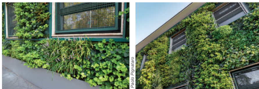
Fig. 4 – Dettagli dello strato vegetativo della parte alta e bassa del greenwall ATM Giambellino
