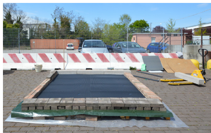
Fig. 4 – Lo strato di drenaggio e accumulo idrico è costituito da pannelli preformati il polistirene
