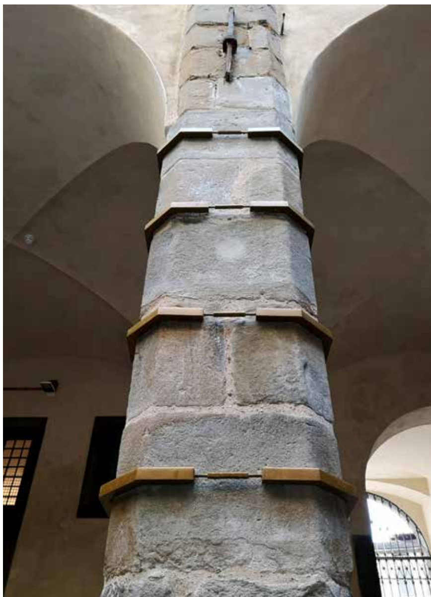
12a. Cinturazione pretesata di una colonna.
