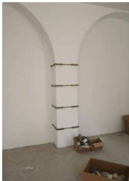
12b-d. Cinturazione pretesata delle colonne e dei maschi murari atta a produrre un confinamento attivo: colonne del cortile al piano terra, colonne lato cortile al piano primo, maschio murario tamponato al piano secondo. Un aspetto tutt'altro che secondario, questo però del progetto architettonico, è stato la definizione del colore da dare alle cinture.
