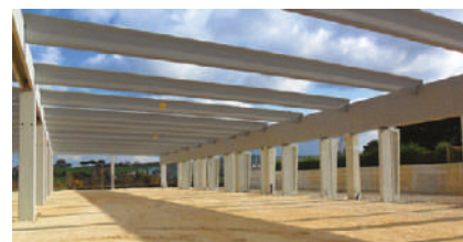
Capannoni in costruzione
