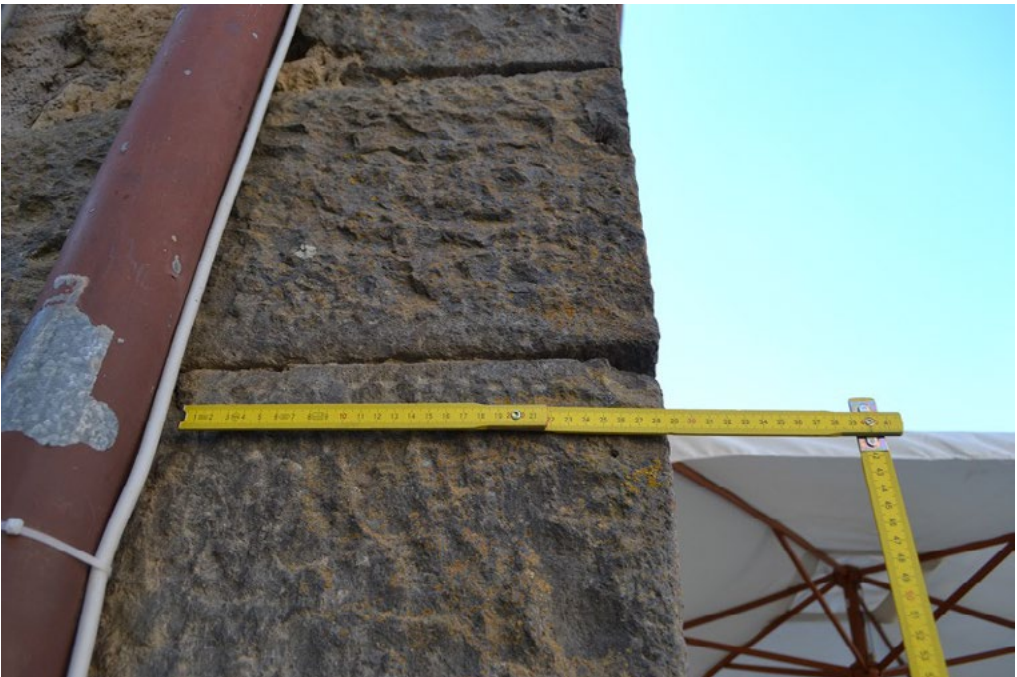
4: Isabella Zamboni, Angolata nord-est del Palazzo Arcangeli, 2016. Conci di Leucite Tefritica squadrati, lavorati a punta con nastrino perimetrale a scalpello.
