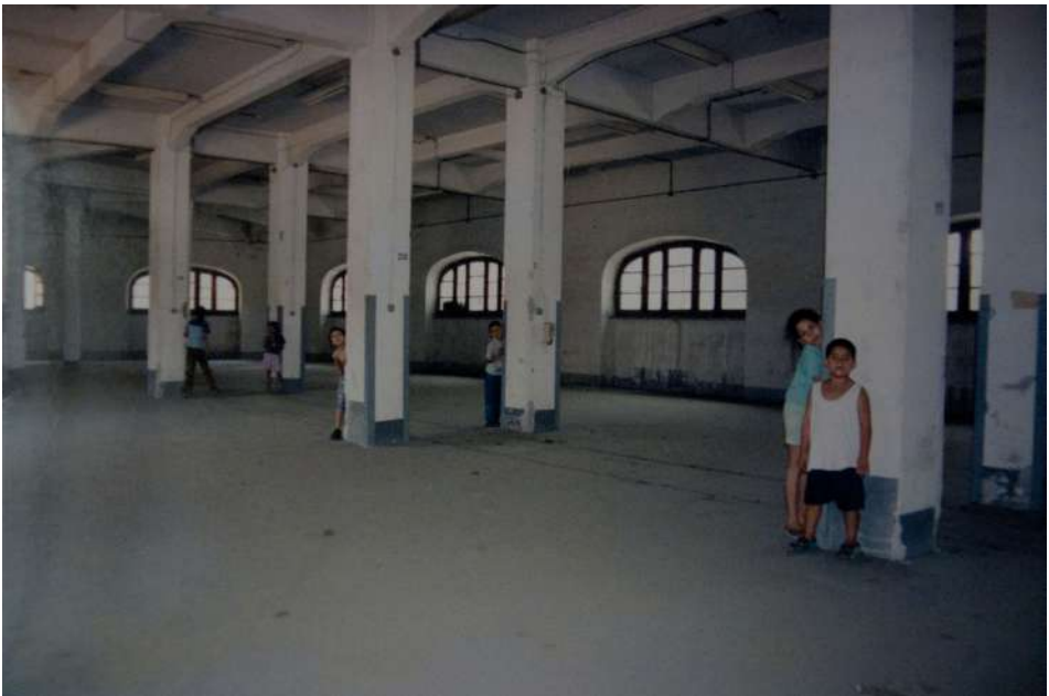
Spazi interni prima dei lavori, foto di Laura Corcuera, 2003
