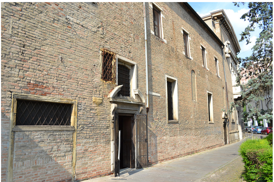
Fig. 1. Scuola del Carmine, vista esterna. Portale di ingresso da Piazza Petrarca.
