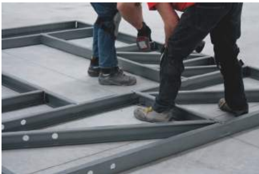
Figura 4. Nastri di lamiera zincata dello spessore di 10/10 mm. Immagine di Valentina Covre.
