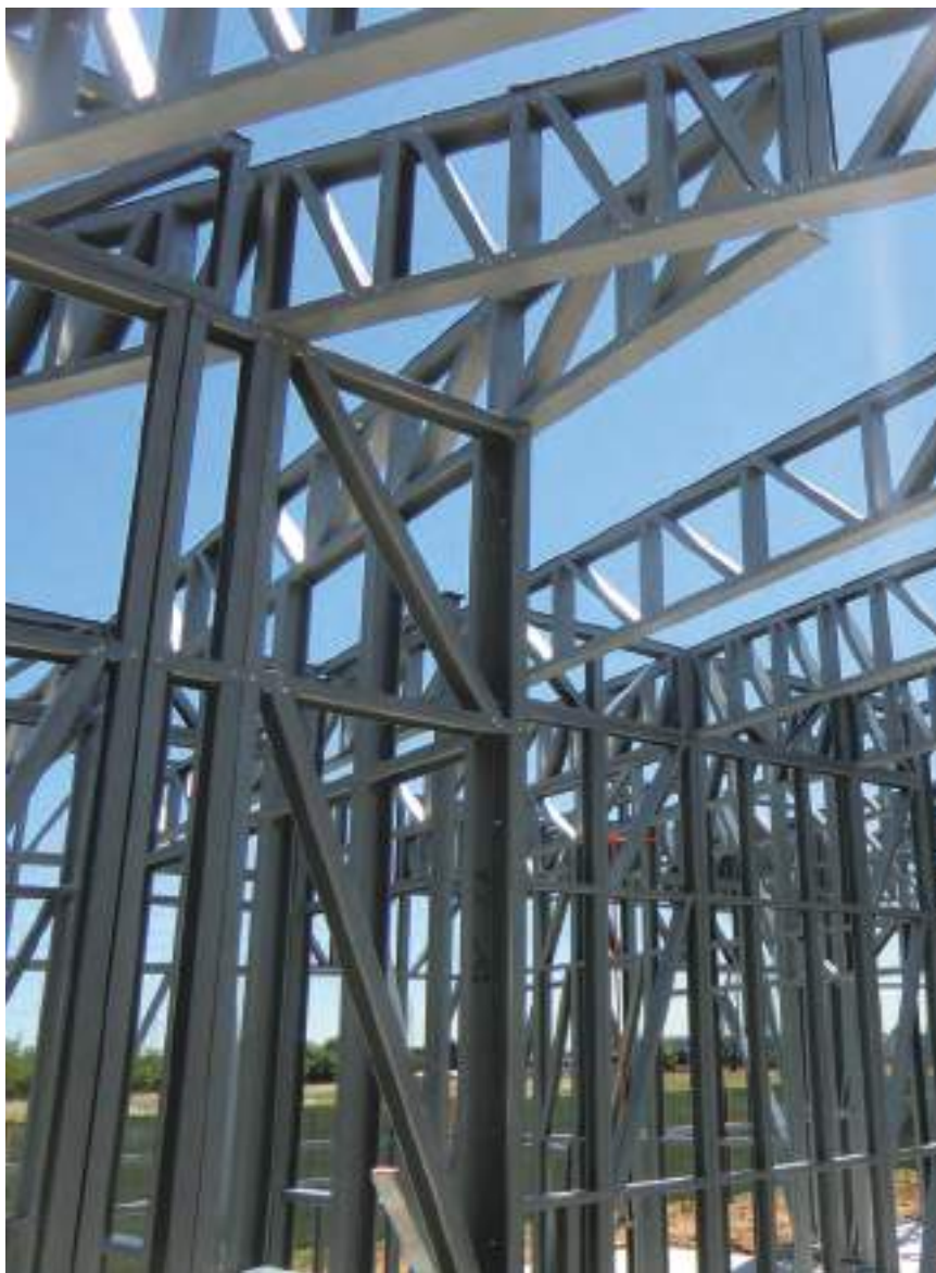
Figura 1. Struttura in acciaio sagomato a freddo, foto di cantiere. Immagine di SPH S.r.l.
