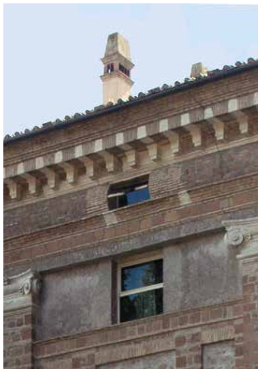
fig. 17 Roma, villa Madama, trabeazione principale del fronte verso il giardino.
