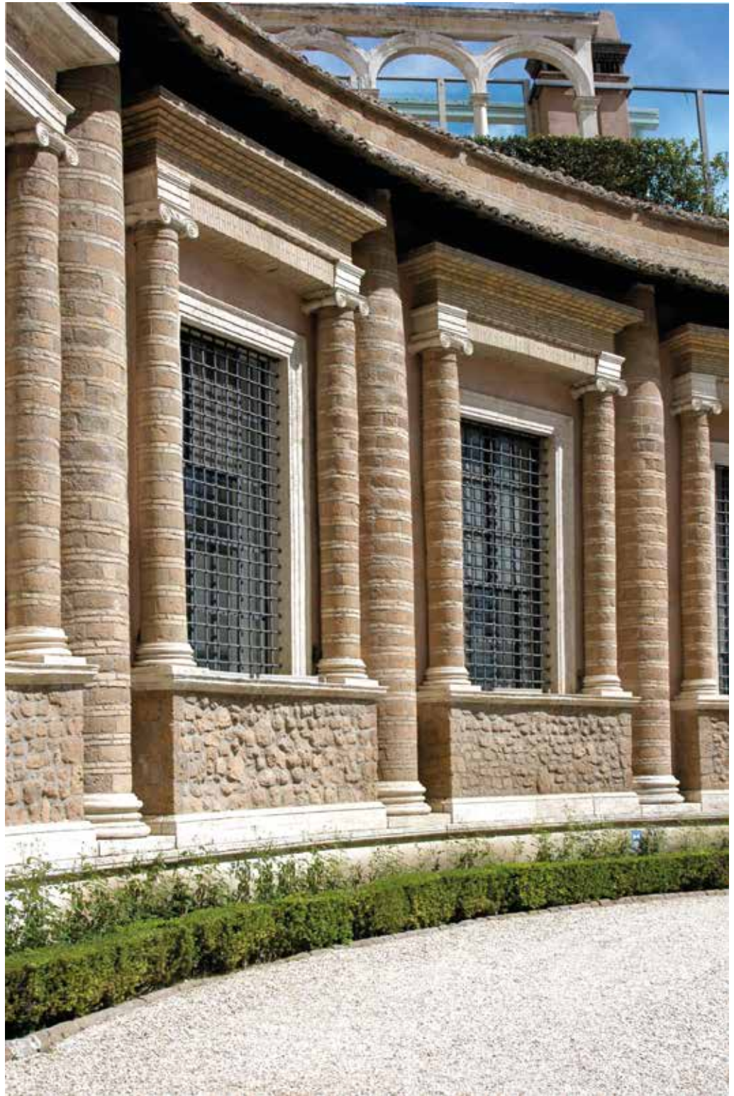
fig. 18 Roma, villa Madama, particolare dell' opus listatum nell'emiciclo del cortile.
