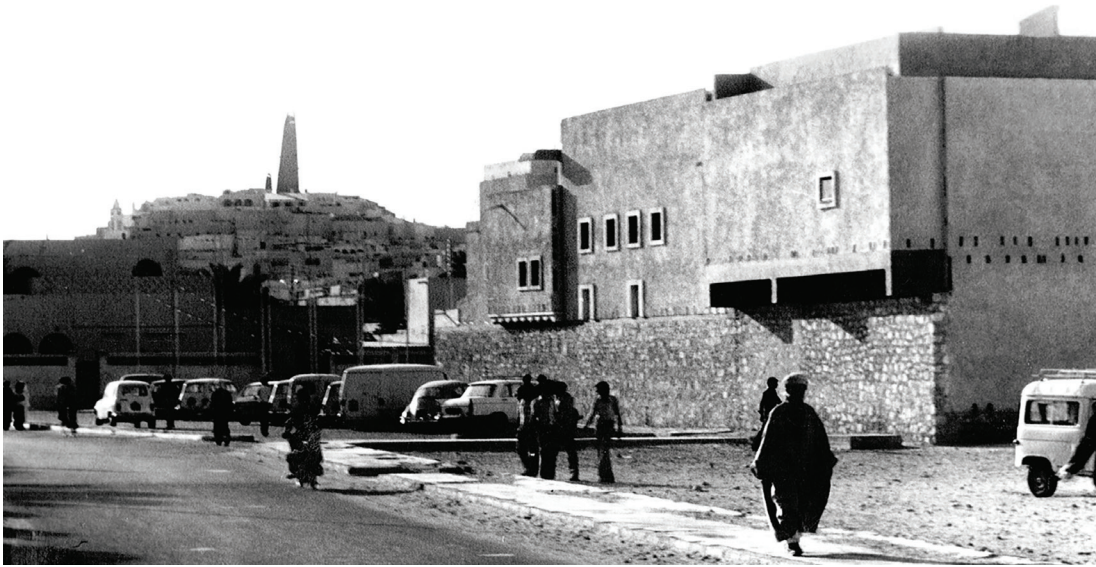
André Ravéreau, Hôtel des Postes di Ghardaïa, 1966-67. Fotografia degli anni Settanta di Manuelle Roche (l'edificio adiacente è stato costruito da Jean-Marc Didillon). © Manuelle Roche/ADAGP
