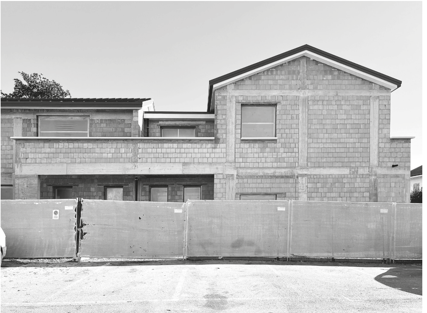
06. Esempio di costruzione a telaio in calcestruzzo | Example of a frame construction in concrete. Chiara Scanagatta
