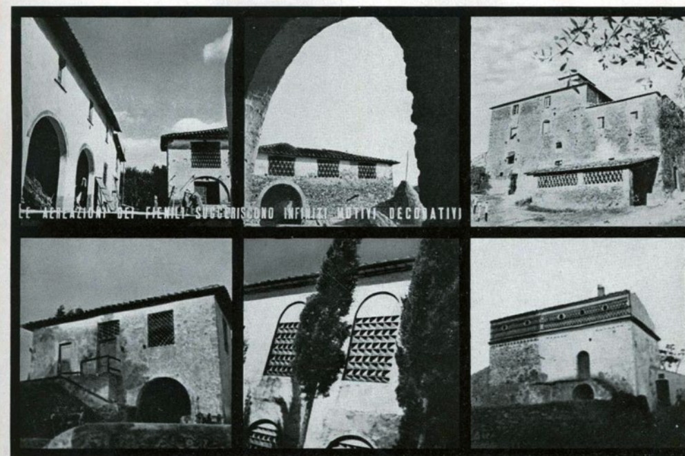
56 - MOTIVI DECORATIVI RICAVATI DALLA LIBERA DISPOSIZIONE DEI MATTONI NELLE FINESTRE DI AEREAZIONE DEI FENILI NELLE CASE DELLA TOSCANA E DELL'ABRUZZO
