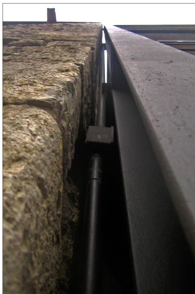
Fig. 8. R. Dalla Negra, P. Ruschi, Corridore dei Fiorentini, Prato. In coincidenza con la nuova struttura di ingresso, la soluzione di continuità definita tra le parti sottolinea l'istituzione di un limite tra presente e passato (foto S. Di Resta)
