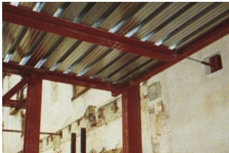
Fig. 5. E. Vassallo, P. Grandinetti: Foresterie Vecchie di villa Contarini Simes a Piazzola sul Brenta (PD). Dettaglio dell'ancoraggio (foto E. Vassallo).
