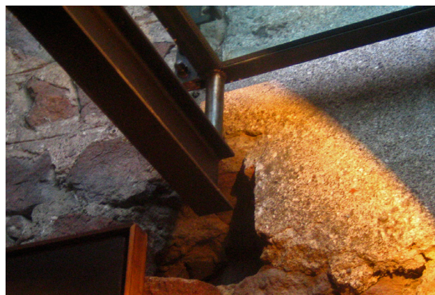
Fig. 10. W. Tscholl, Castel Firmiano, Bolzano. I profili che compongono il nuovo solaio sono posizionati alla quota degli alloggiamenti delle orditure lignee perdute. L’incastro è evocato ma non raggiunto: il nuovo inserimento non istituisce alcun contatto diretto con il paramento murario (foto S. Di Resta).
