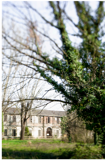
Fig. 5. Ex ospedale psichiatrico di Rovigo. Padiglione n. 5. Esterno 2015 (foto L. Luiiu).
