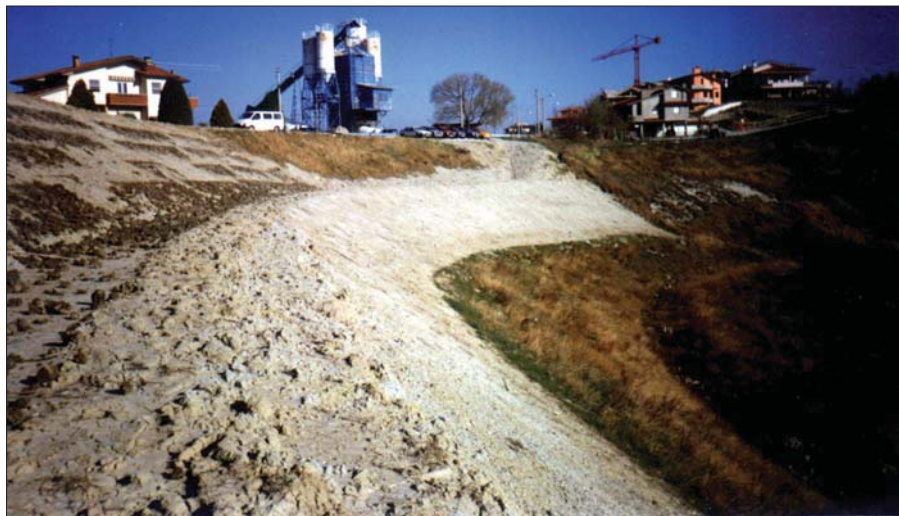
Figura 12 – Interventi stabilizzanti con vimate di Tamerici su calanchi loc. Ventoso (S. Marino anni '80) in corso d'opera (foto Sauli)
