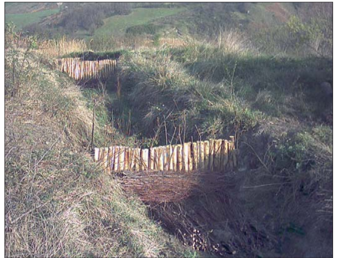
Figura 11 – Palizzata per impluvi in erosione (aprile 2003) - Foto Archivi Dipartimento Territorio e Ambiente RSM
