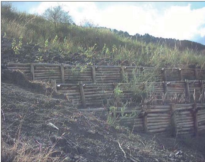
Figura 10 – Briglia viva in legname impiegata per il consolidamento di una nicchia smottata (settembre 2003) - Foto Archivi Dipartimento Territorio e Ambiente RSM
