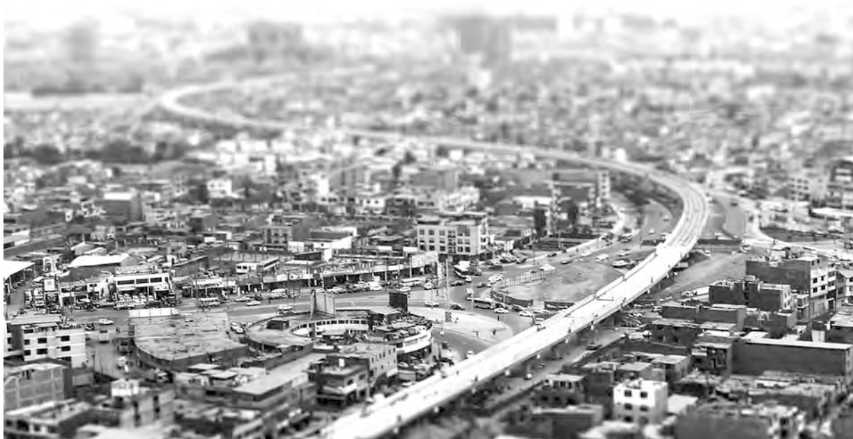
Viaducto de la metropolitana, Lima. Foto: A. Bonadio.
