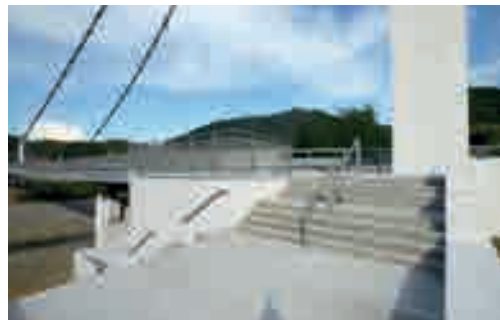
03 | Dettagli del radicamento al suolo e del basamento con belvedere del ponte di Stadano caratterizzato dalla singola antenna che sostiene entrambe le catenarie.
