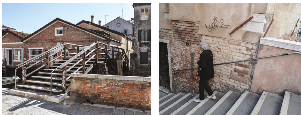
Figura 3. Esempi di ponti in legno e in muratura su cui sono stati installati corrimano in acciaio per facilitarne il superamento.
