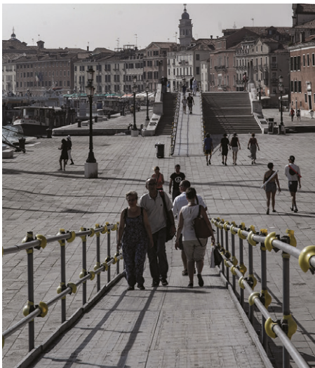
Figura 2. Esempi di ponti accessibili: a sinistra le rampe temporanee della Venicemarathon; a destra il ponte Contarini con installate piccole rampe di raccordo utili per il superamento con carrelli della spesa.
