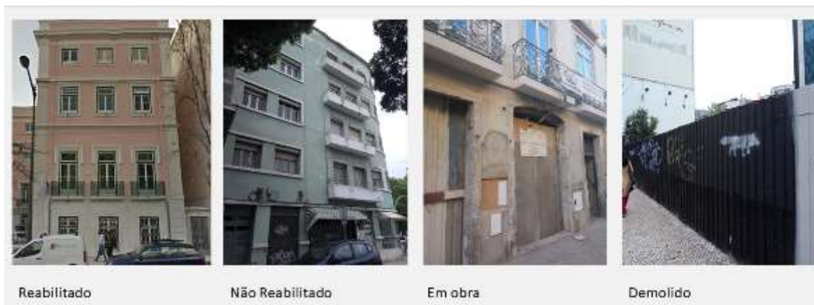
Figura 4: Estado atual dos edifícios devolutos em 2009 nas freguesias de Santa Maria Maior e Avenidas Novas. Fonte: levantamento urbanístico, maio e junho de 2018
