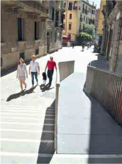
_Vista della rampa verso calle de le Sechere e dettaglio del corrimano presente sulla sommità del ponte, preesistente alla collocazione delle rampe.
