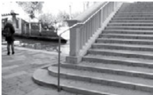
_Ponte Foscari sul rio Novo, con parapetto in pietra. In questo ponte molto trafficato che si trova in una zona aperta e poco protetta dalle folate di vento è stato collocato un corrimano in acciaio inox connesso alla pietra che si curva fissandosi a terra.
