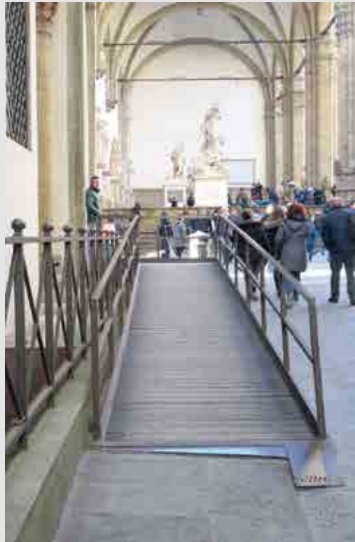
_Rampa di accesso al loggiato delle Gallerie degli Uffizi, Firenze.
