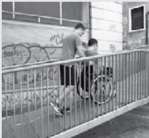
_Superamento del ponte delle Sechere dotato di rampe con gradino agevolato. Per il superamento di questo tipo di rampa le persone con carrozzina manuale hanno quasi sempre necessità dell'aiuto di un accompagnatore.
