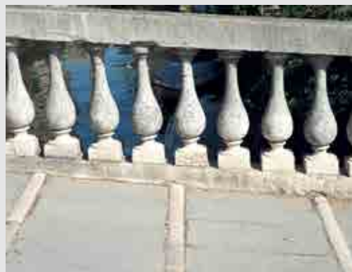
Il ponte dei Giardini. Vista verso il canale e dettaglio dei gradoni in trachite raccordati da listelli in pietra d'Istria.
