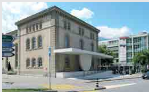
_Nuovo ingresso della sede del Parlamento del Canton Grigioni, Coira, Svizzera, 2010, Arch. Valerio Olgiati. Il progetto dà risposta all'esigenza di accessibilità mediante un sistema che si costituisce come nuovo ingresso coperto e rampa d'accesso, tramite una soluzione che risolve il problema del dislivello contribuendo a definire il rapporto dell'edificio con la piazza anche grazie al disegno della pavimentazione che amplia la superficie di pertinenza. Tutti gli elementi sono in calcestruzzo gettato in opera formato da cemento bianco, calcare del Giura e ghiaia di Coira. Le superfici di passaggio sono levigate e bocciardate.
