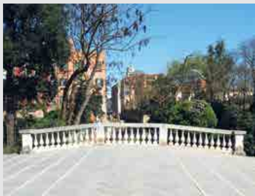
Il ponte dei Giardini. Vista verso il canale e dettaglio dei gradoni in trachite raccordati da listelli in pietra d'Istria.
