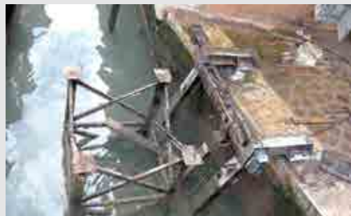
«Il 'Caregon' in uso sul rio Malpaga dal 2005 al 2009 e dettaglio della struttura durante le operazioni di smontaggio, in cui si può notare l'effetto dell'aggressione dell'acqua salmastra ai profili in acciaio.
