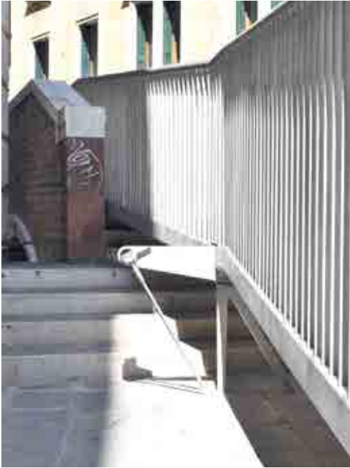
_Dettaglio del cavalletto che sostiene la rampa. Ogni elemento poggia su due sostegni: il primo è il punto di contatto del percorso con la fondamenta, il secondo, posizionato in corrispondenza del primo gradino del ponte, è un cavalletto eccentrico con colonnine in acciaio inox.
