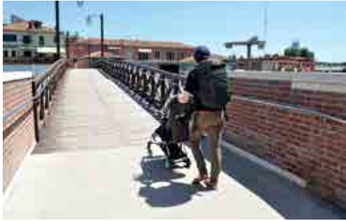
_Viste generali del ponte.
