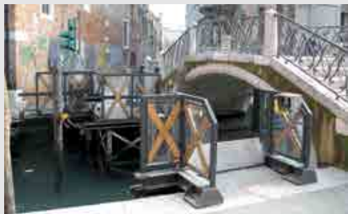
«Il 'Caregon' in uso sul rio Malpaga dal 2005 al 2009 e dettaglio della struttura durante le operazioni di smontaggio, in cui si può notare l'effetto dell'aggressione dell'acqua salmastra ai profili in acciaio.
