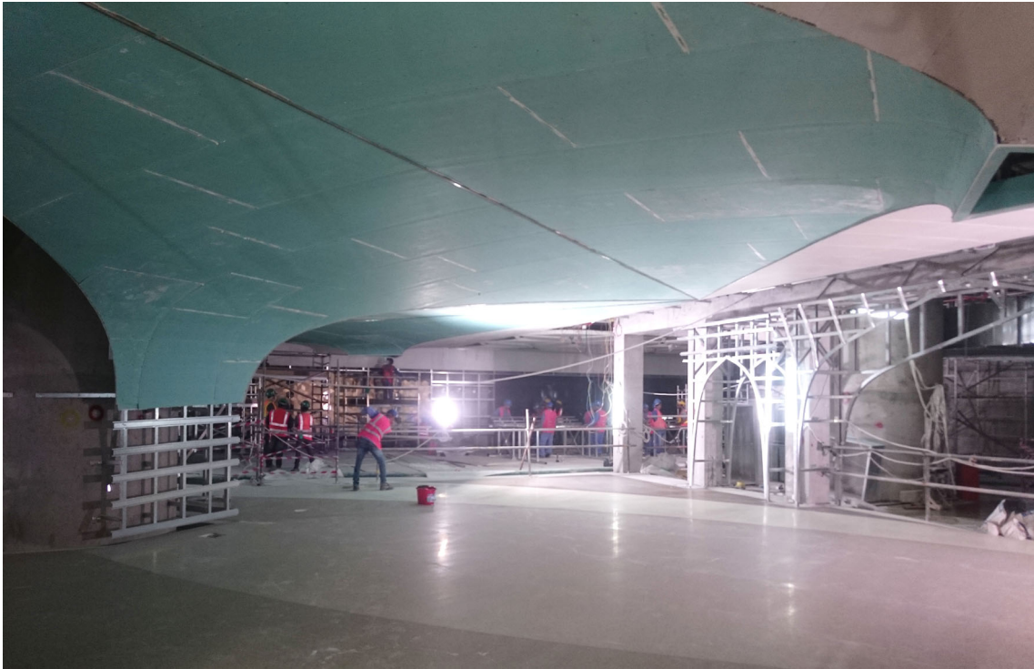
Illustrazione 94: Foto di cantiere con un ambiente voltato in fase di realizzazione al livello mezzanino della stazione di Msheireb, marzo 2018 (foto di Marco Nonveiller)
