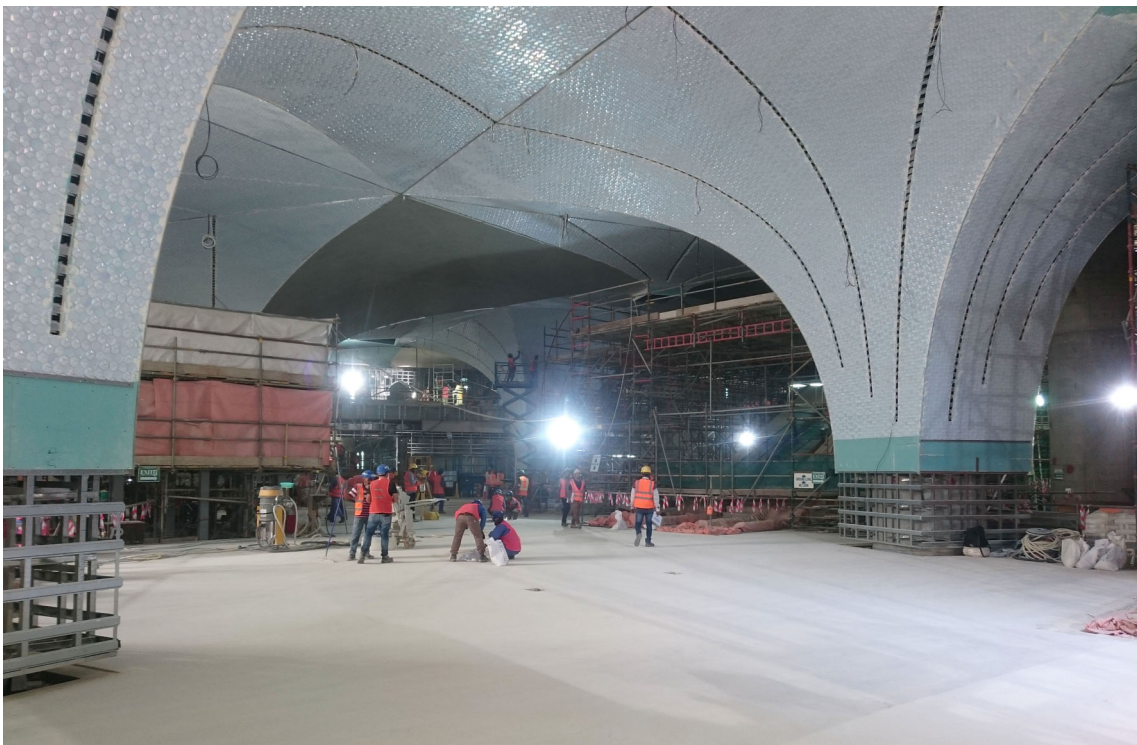
Illustrazione 95: Foto di cantiere con l'ambiente voltato a doppia altezza in fase di realizzazione del livello concourse della stazione di Msheireb, marzo 2018 (foto di Marco Nonveiller)
