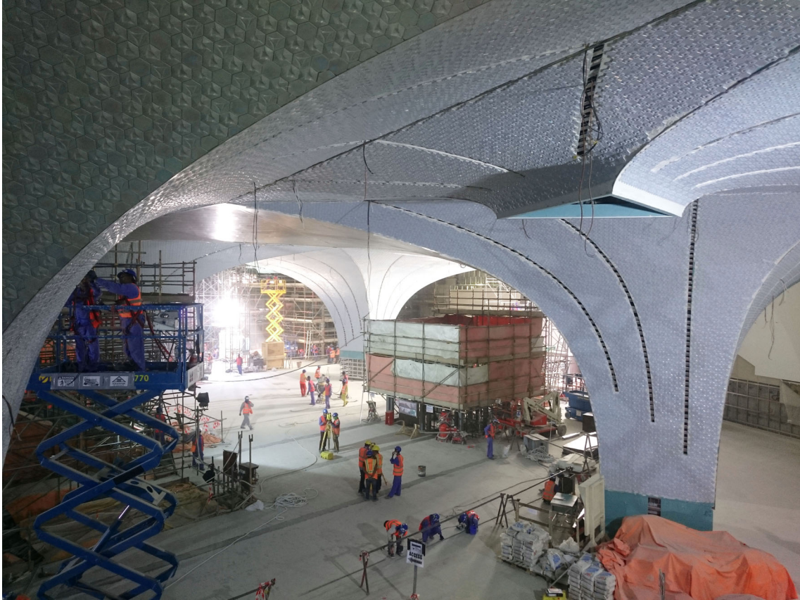
Illustrazione 96: Foto di cantiere con l'ambiente voltato a doppia altezza in fase di realizzazione del livello concorse della stazione di Msheireb, marzo 2018 (foto di Marco Nonveiller)
