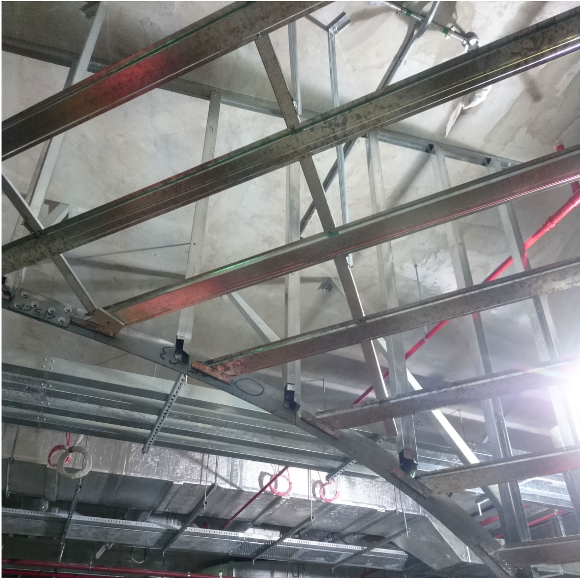
Illustrazione 93: Foto di cantiere con la realizzazione del primo mock-up di un ambiente voltato al livello mezzanino della stazione di Msheireb, luglio 2017; si nota lo steel plate curvilineo al quale sono stati fissati i profili a sezione di omega per definire la curvatura della faccia della column vault (foto di Marco Nonveiller)
