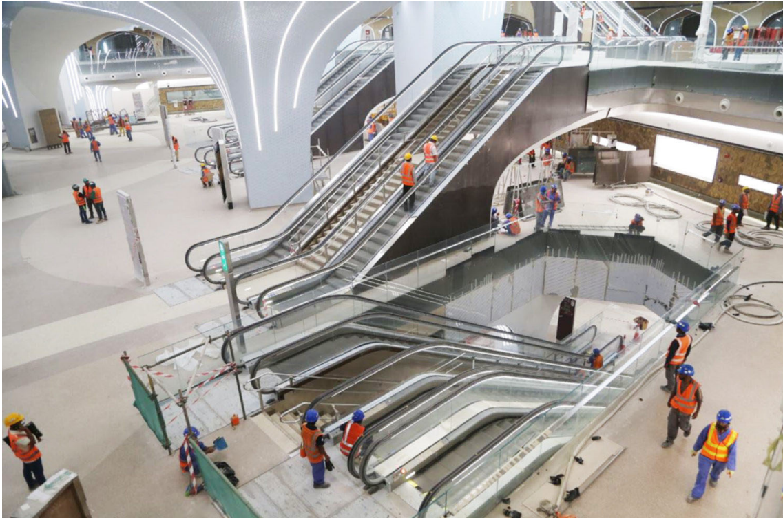
Illustrazione 97: Foto di cantiere in fase avanzata con l'ambiente voltato a doppia altezza del livello concourse della stazione di Msheireb, dicembre 2018 (fonte Qatar Rail)
