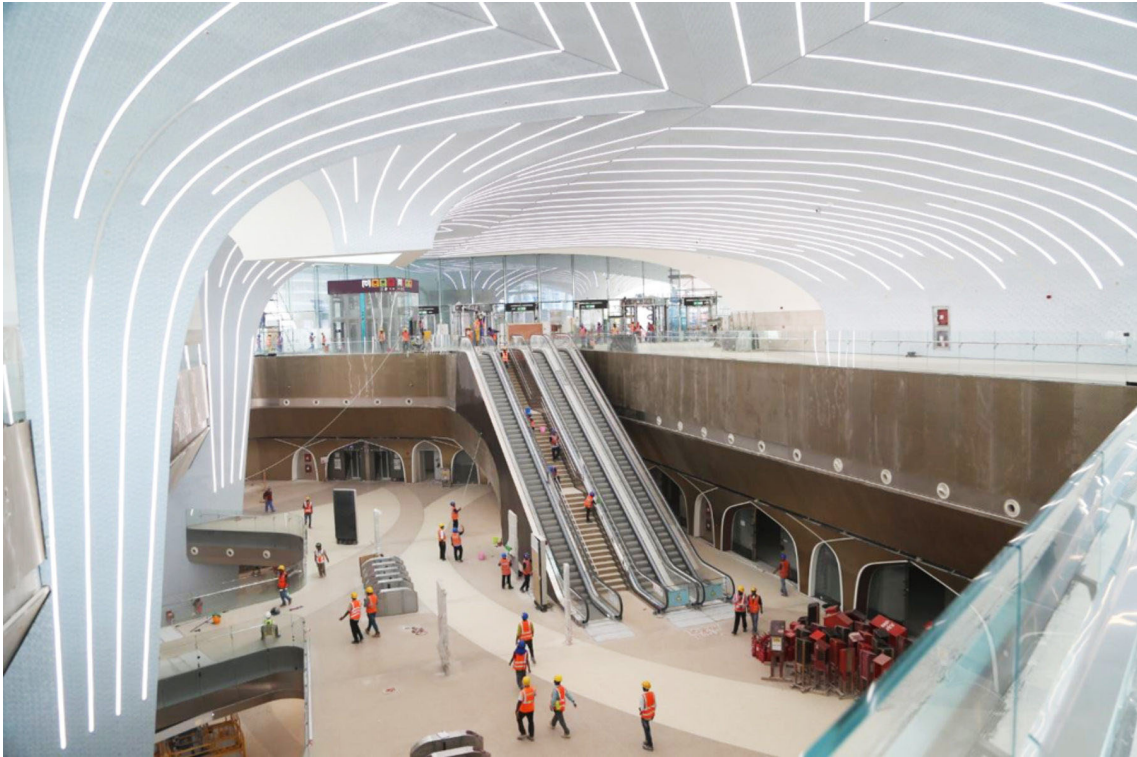
Illustrazione 98: Foto di cantiere in fase avanzata con l'ambiente voltato a tripla altezza tra livello concourse, mezzanino e at grade della stazione di Msheireb, dicembre 2018 (fonte Qatar Rail)
