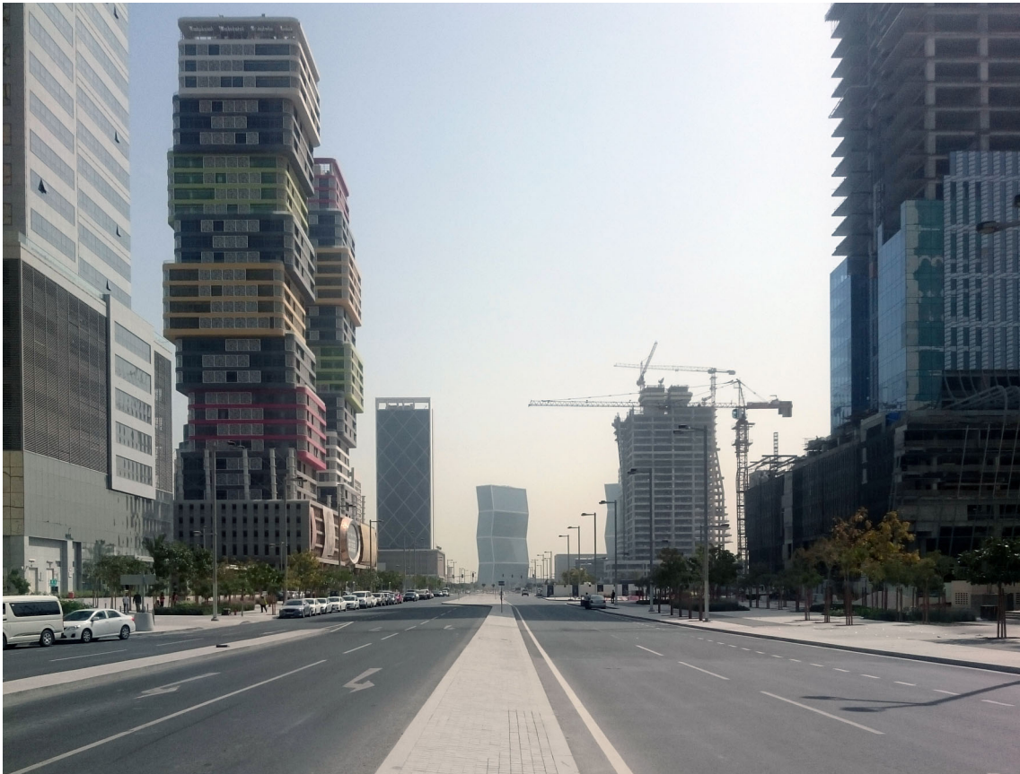
Illustrazione 23: Vista di una delle avenue di Lusail City con diversi edifici per uffici in corso di costruzione, gennaio 2018 (foto di Marco Nonveiller)
