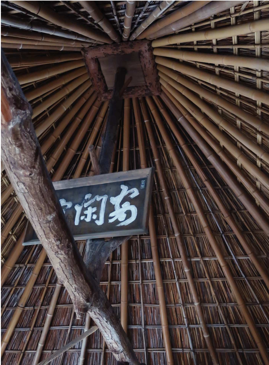
[44] Sen-no-Rikyū, Kasa-tei [傘亭, “padiglione ombrello”], vista interna della copertura.
