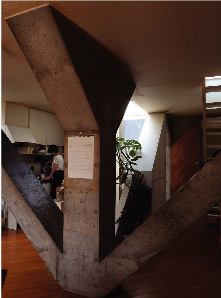
[112] Casa a Uehara , vista dal soggiorno del lucernaio e di una delle due porte d'entrata.
