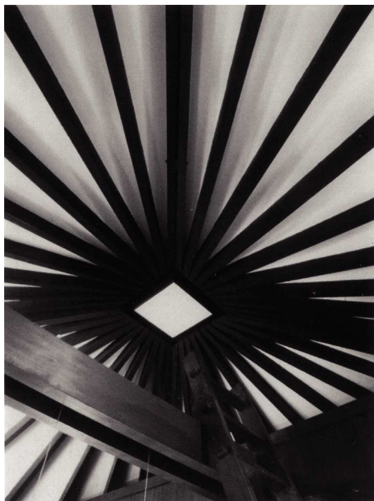
[46] Casa Ombrello , vista interna della copertura.
