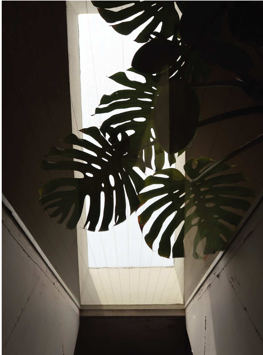
[84] Casa a Uehara , vista del lucernaio inclinato posto sopra il vano della scala d'accesso.
