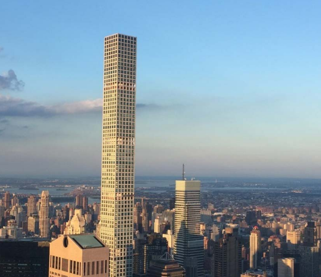
Figura 1: 432 Park Avenue, New York. Edificio residenziale considerato “snello” per l’evidente sproporzione tra altezza e dimensione in pianta.
