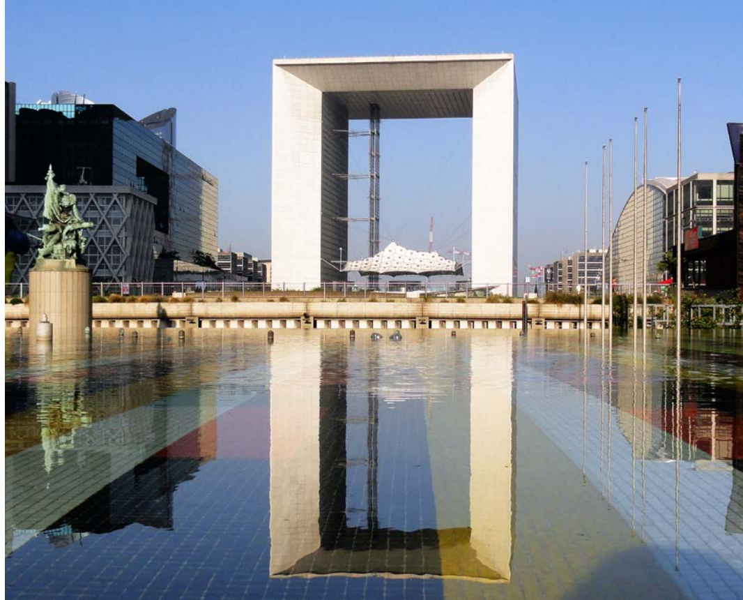
Figura 10: La Grande Arche, Peteaux fuori dalle porte di Parigi, un enorme cubo, 111 metri per lato, svuotato al centro e che ospita uffici. Fonte. wikimedia
