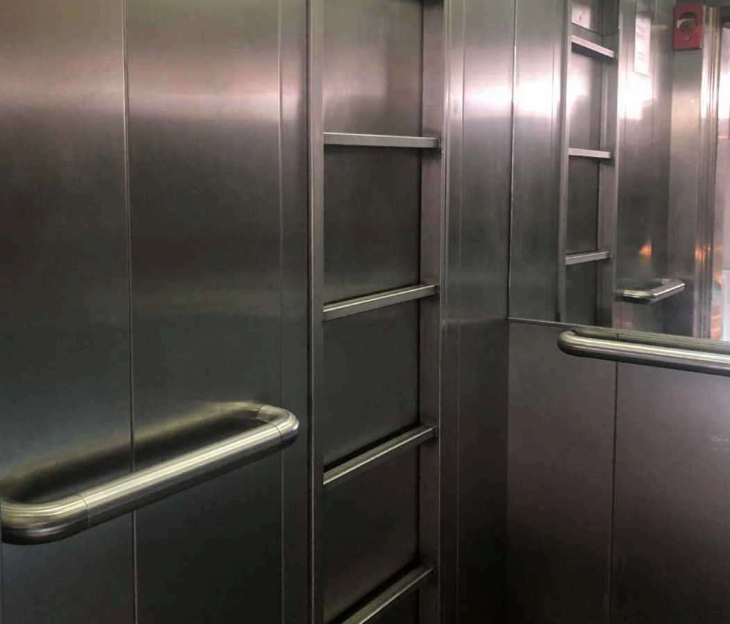
Figura 14: Un esempio in cui è stato predisposto una soluzione per facilitare la discesa degli operatori o la salita dei passeggeri in caso di necessità.
