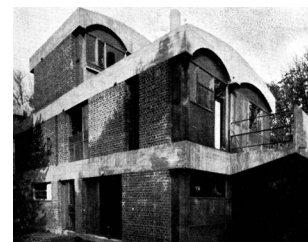
immagini: Maison week-end Jaoul dall'alto: progetto preliminare, Le Corbusier, Parigi, 1937 fonte: M. Bill, Le Corbusier et Pierre Jeanneret: oeuvre complete 1934- 1938 , Birkhäuser, Basel, 1999
