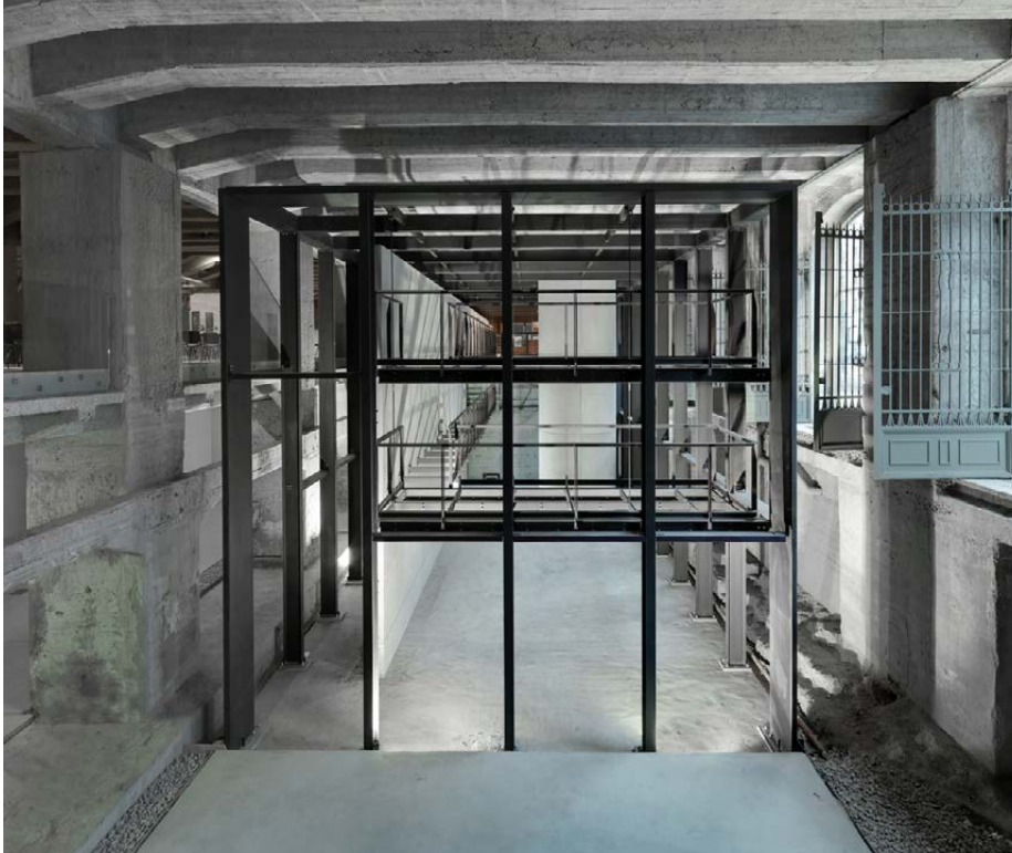
Figura 6. La biblioteca in fase di completamento (foto A. Martiradonna).
