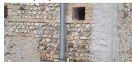
2. Traccia del prolungamento del muro
