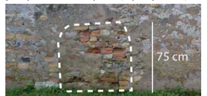
3. Tamponamento di un'apertura (a quota più bassa)
