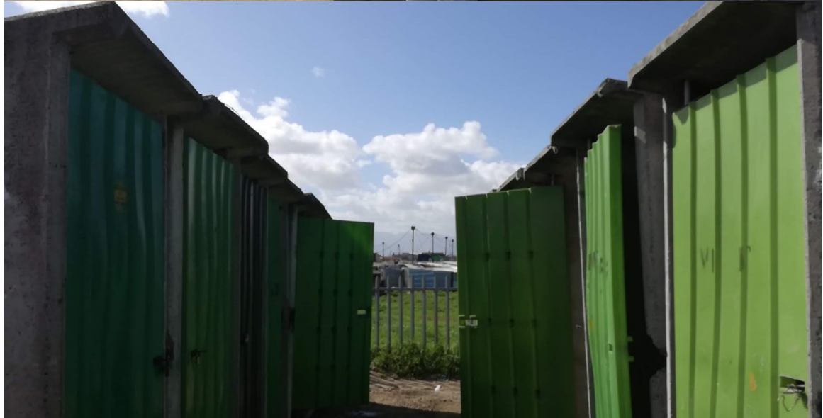
Figura 55 - Punto acqua e bagni dell'insediamento S Section. Fonte autrice, 2019
