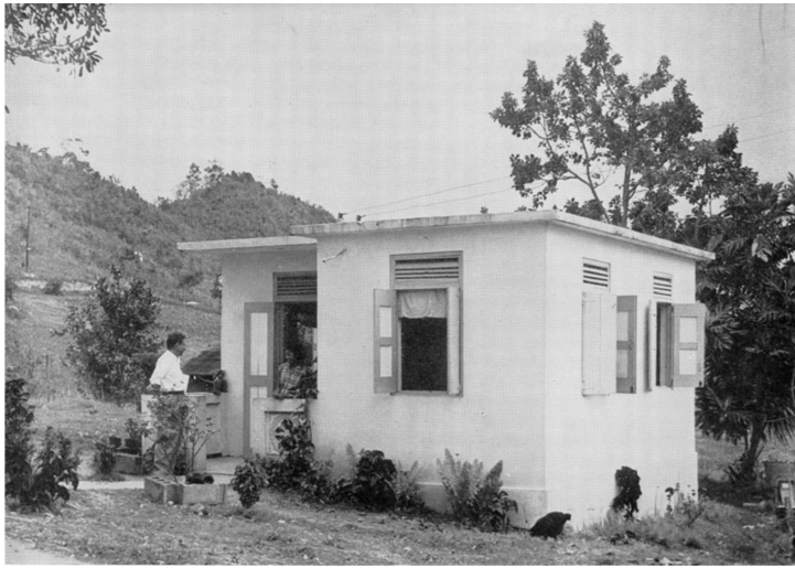
Ilustración 1.—Tienda construida bajo el programa de ayuda propia y ayuda mutua con cooperación del gobierno.
