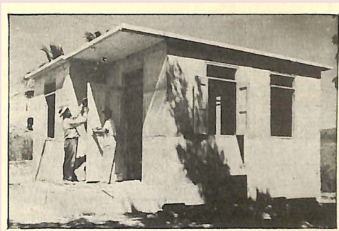
07 Ultimato il tetto vengono montati gli infissi
