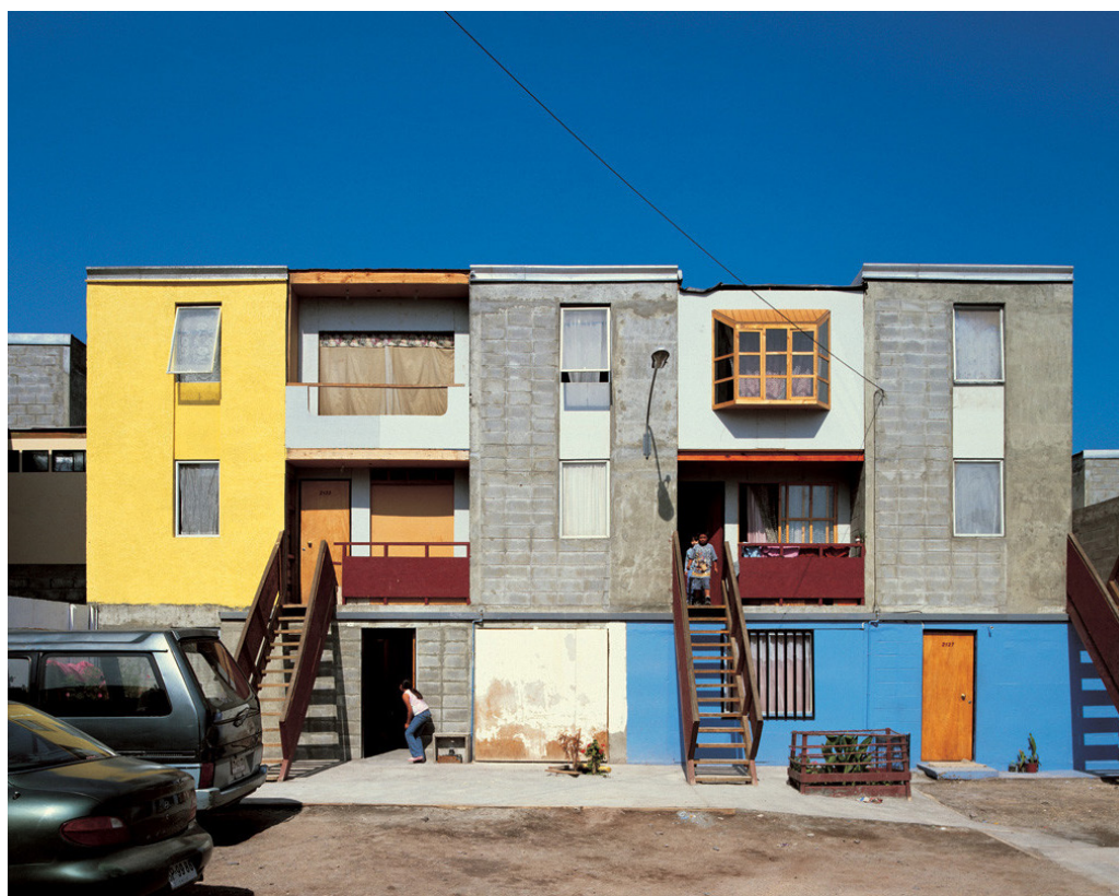
Immagini 83-84 Vista panoramica del progetto Elemental nella sua fase iniziale e dopo l'ampliamento delle abitazioni da parte degli abitanti.
