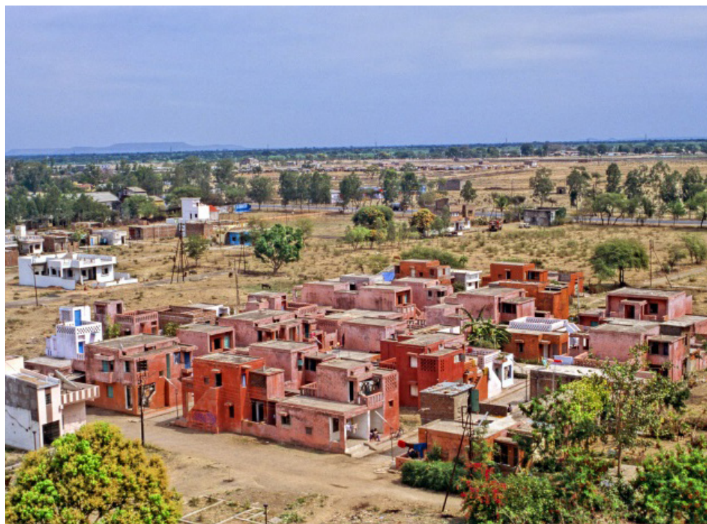
Immagine 81-82 Vista panoramica del progetto Aranya Community Housing nella sua fase iniziale e dopo la realizzazione delle case prototipo.
