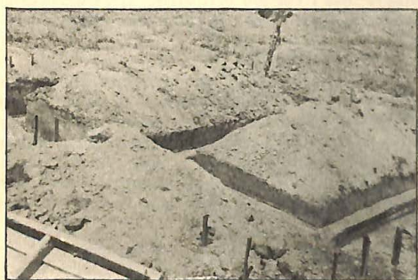
02 Scavo delle fondazioni
