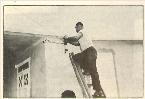
08 Montaggio dell'impianto elettrico
