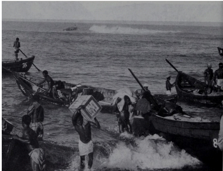
Immagine 32 Scarico di elementi prefabbricati in Ghana prima della costruzione del molo. (C.ABRAMS, op. cit. , 1964.)
