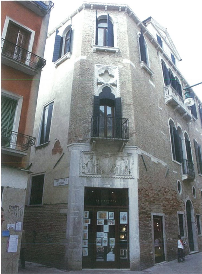
Figura 8 - Palazzo Soranzo Pisani a S. Agostin. Vista del fronte in diagonale con il portale. Tratto da F. Doglioni, A. Squassina, F. Trovò, Assetti intenzionali a entro-piombo nell'edilizia civile, [2], in Doglioni, F., Mirabella Roberti, G., (a cura di), "VENEZIA, forme della costruzione - forme del dissesto", [1], p. 165.
