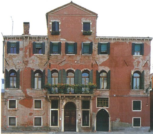
edificio 5: campo S. Angelo Raffaele
