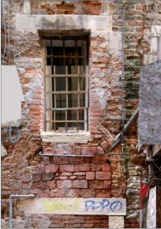
Fig. 8a-b. Calle delle Oche (sec.XIII-XIV): edificio con muratura mista in mattoni romanici grandi nelle pareti di fondo e mattoni sottili nella ghiera dell'arco (fotomosaico: arch.Michele Bondanelli)
