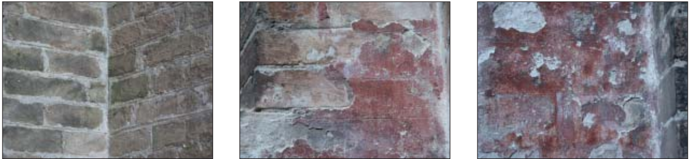
Fig. 20a-c. Complementarietà funzionale e rimandi figurativi fra muratura costruita e muratura simulata nelle finiture medioevali veneziane: la stilatura sottile nella muratura gotica (20a) viene ripresa dall'intonaco a finta cortina ( regalzier ) che presenta finti giunti stilati (20b), ripassati con colore nero che conferisce effetto chiaroscuro (20c)
