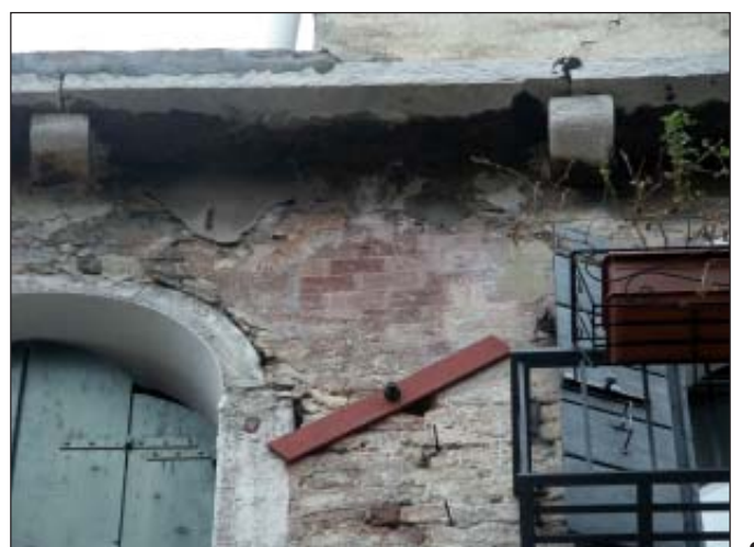
Fig. 23a-c. Esempi di regalzier: (a) regalzier bianco in un edificio in salizada S.Stae; (b) regalzier a velatura sul campanile della chiesa dei Frari; (c) regalzier bicromo in corte Nuova S.Lorenzo
