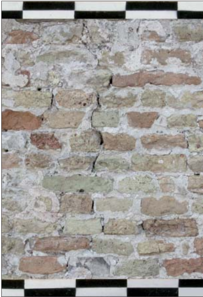
Fig. 5. Campione di muratura eterogenea con mattoni romani di reimpiego (Chiesa di S.Giacomo dell'Orio)
