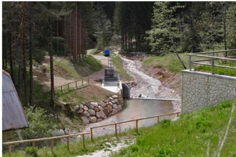
Figura 2 | Due "mini" impianti sul torrente Piova (BL). Sulla destra del corso d'acqua si vede una "mini" centrale con il relativo scarico e a sinistra, a pochi metri, un'ulteriore opera di presa. Si notano inoltre diverse trasformazioni del paesaggio: costruzione scogliera, briglia e strada; modifica dell'alveo; abbattimento alberi; sbancamento del terreno e alterazione del flusso idrico.
