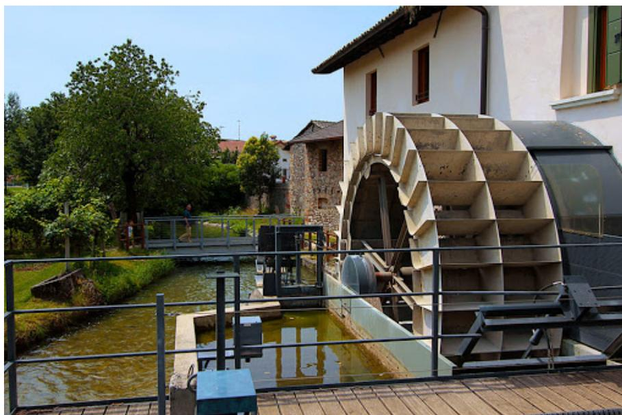
Figura 6 | Restauro del mulino di Adigliaccio (UD). L’impianto meccanico è stato trasformato per la produzione di energia elettrica.
