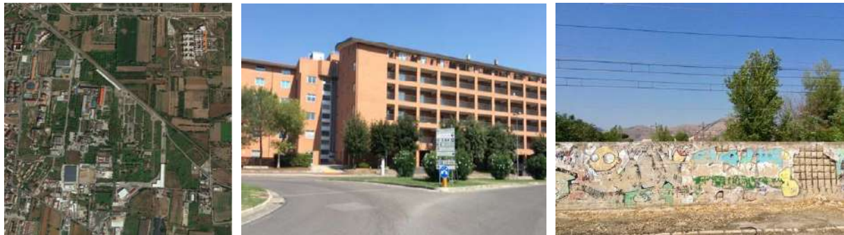
Figura 2 | Le ex-aree produttive del territorio periurbano (a sinistra); l'area già riconvertita della ex Saint Gobain (al centro); la barriera ferroviaria (a destra) Fonte: Google Earth (a sinistra), fotografia delle autrici (al centro, a destra).
