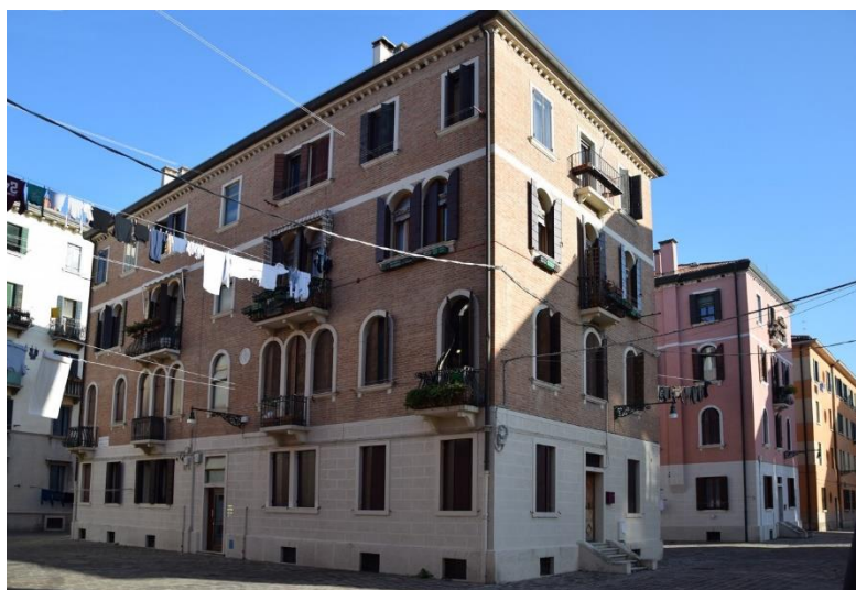
Figura 36 – Vista fotografica di un edificio del quartiere durante il sopralluogo.
