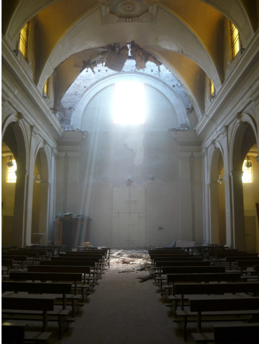
Figura n° 45 - 46: il crollo delle strutture di copertura della prima campata. Le due fotografie risalgono al giorno successivo della prima scossa del 20 maggio 2012.
