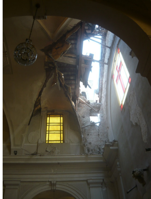
Figura n° 45 - 46: il crollo delle strutture di copertura della prima campata. Le due fotografie risalgono al giorno successivo della prima scossa del 20 maggio 2012.
