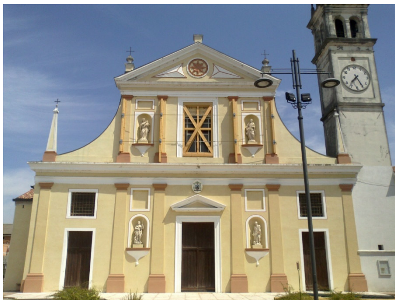
Figura n° 38: il prospetto principale ad opere provvisorie compiute.
