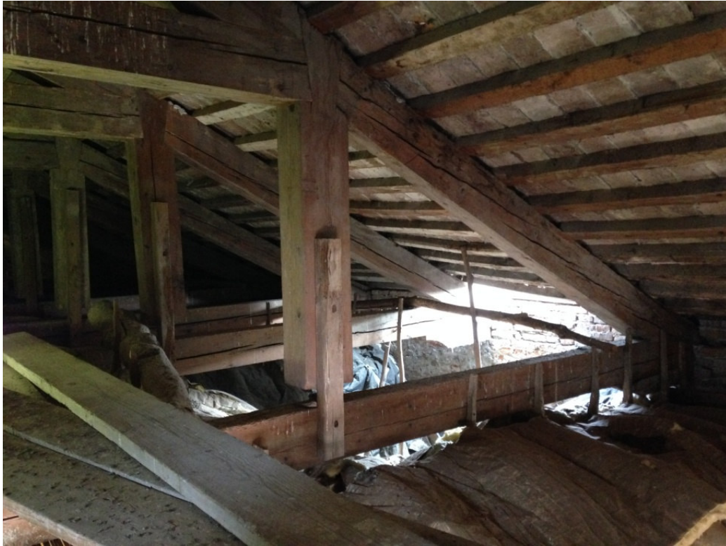
Figura n° 42: particolare delle capriate lignee della copertura a inizio dei lavori opere di consolidamento post sisma.
