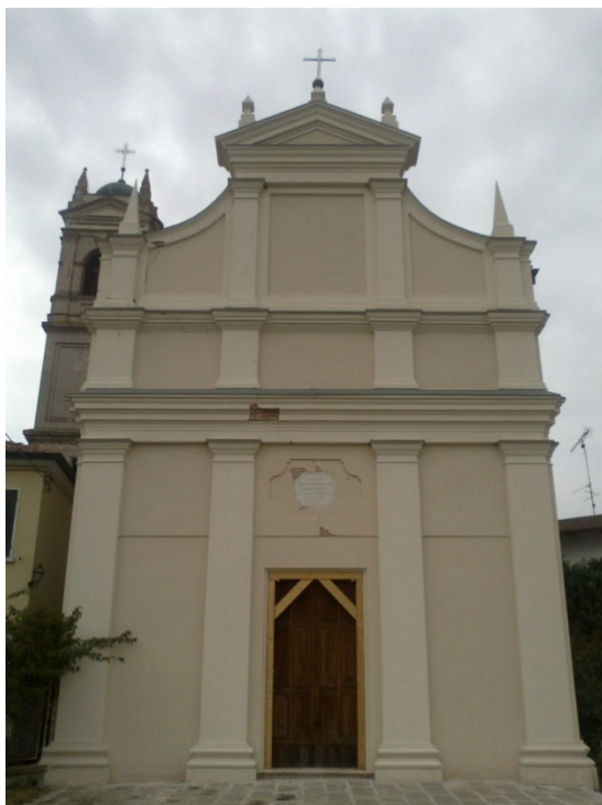
Figura n° 12: Le lesioni prospettiche e l'opera provvisoria di sbadacchiatura del portale.
