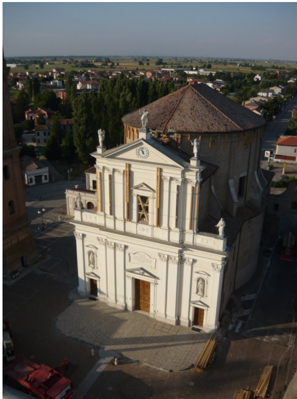
Figura n° 35: veduta a volo di uccello a opere provvisionali concluse.
