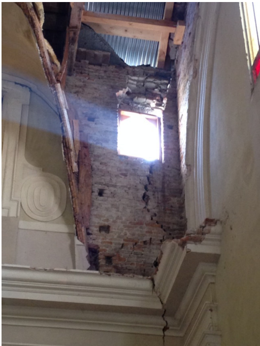
Figura n° 47 - 48: lo strappo tra la facciata e le murature di spina. Le lesioni sono state rilevate fino alla quota del pavimento interno. La presenza della finestra per l'accesso al sottotetto ha contribuito all'innesco del crollo della copertura.
