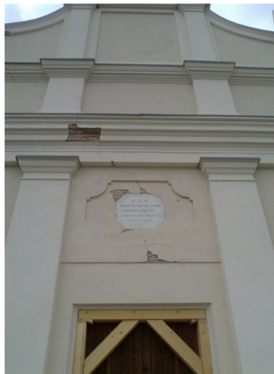
Figura n° 12: Le lesioni prospettiche e l'opera provvisoria di sbadacchiatura del portale.
