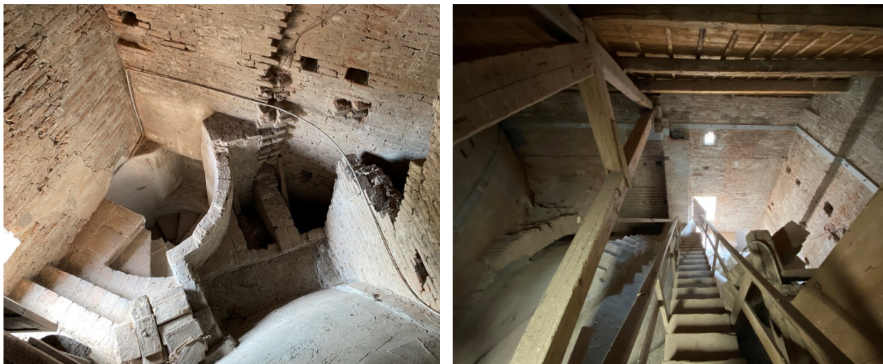
Figura n° 27: la scala di arrivo alla copertura e l'imposta della volta in muratura dell'atrio di ingresso. Figura n° 28: il volume tra la facciata (a sx) e il tamburo dell'aula dei fedeli (a dx). In evidenza la cordolatura intermedia in piastre in ferro realizzata quale miglioramento della vulnerabilità sismica della facciata a seguito del sisma 2012.
