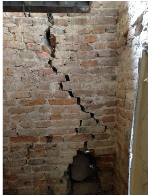
Figura n° 47 - 48: lo strappo tra la facciata e le murature di spina. Le lesioni sono state rilevate fino alla quota del pavimento interno. La presenza della finestra per l'accesso al sottotetto ha contribuito all'innesco del crollo della copertura.
