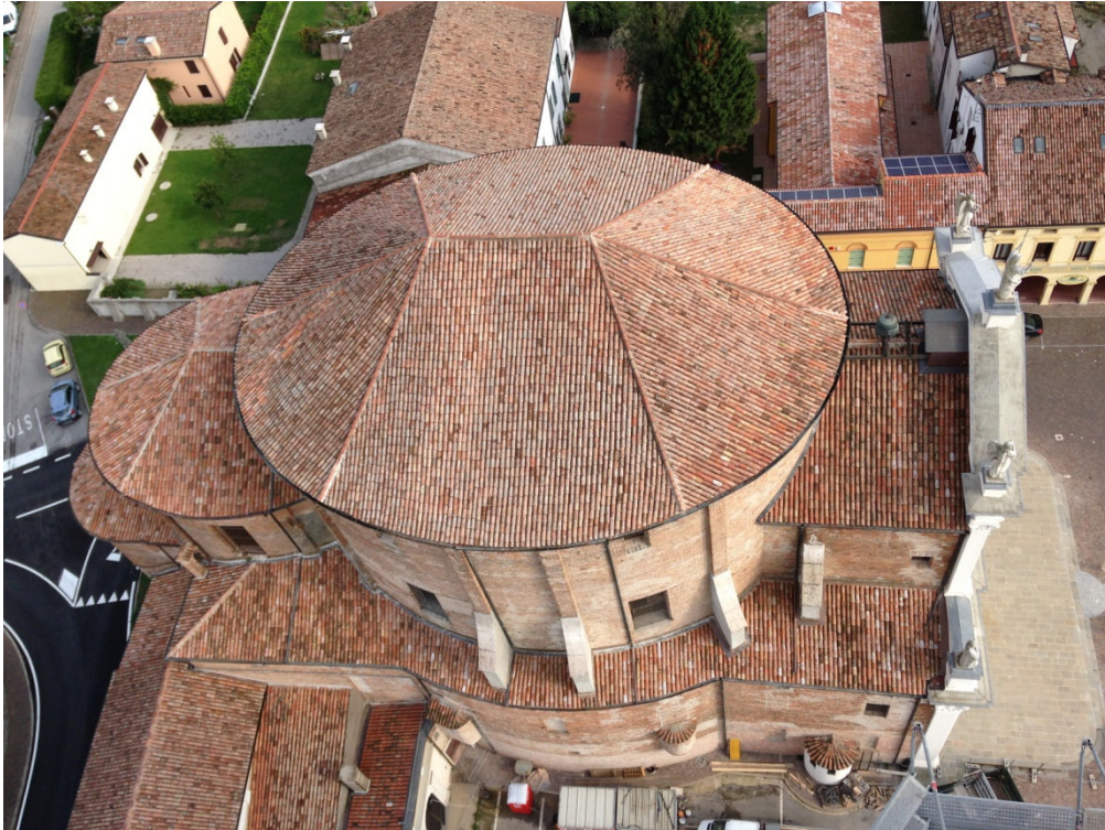
Figura n°22: vista delle coperture della parrocchiale dalla sommità del campanile adiacente.
