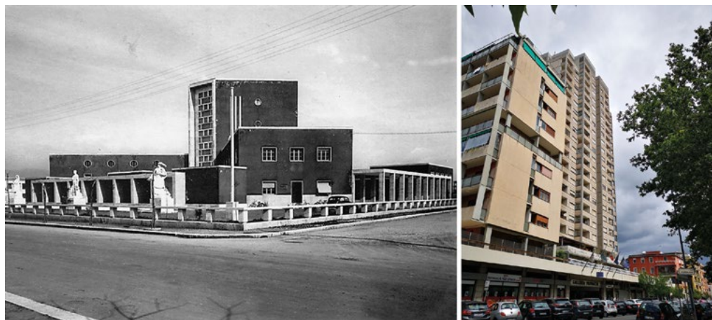
4: A sinistra, la Casa dell'Agricoltore nel 1948 [Archivio della Casa dell'Architettura di Latina]. A destra, la Galleria Pennacchi edificata al suo posto tra il 1967 e il 1970 [Fotografia di Di Resta 2019].
