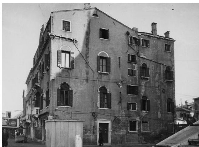
Figg. 6-7. Venezia. Palazzo Adoldo, le facciate esterne prima dell'intervento di restauro (IUAV, AP, FFT, Forlati 2.1 Progetti e concorsi/045).
