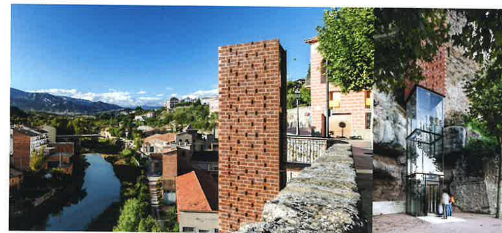
Fig.02 L'ascensore che connette Gironella al suo centro storico. Fonte: https://www.carlesenrich.com/projects/gironellas-new-access/
