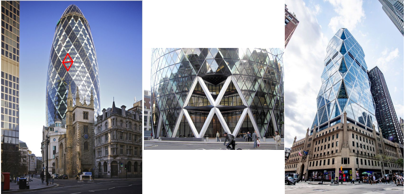
Figura 4 – Sinistra e centro: 30 St. Mary Axe (in rosso due maglie del diagrid ). Destra: Hearst Tower.
