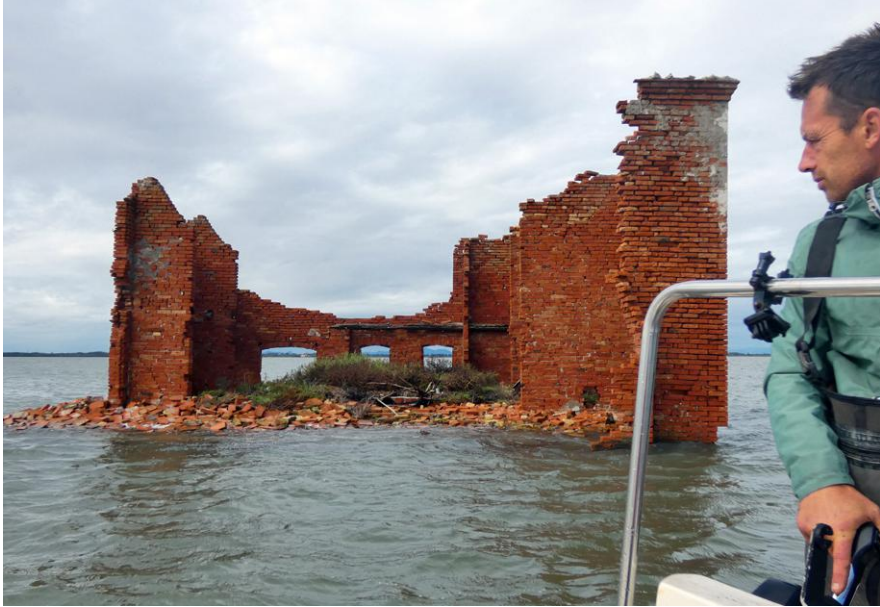
14. Il Casone Prime Poste e gli elementi costruttivi superstiti durante un sopralluogo. Foto di C. Toson.
