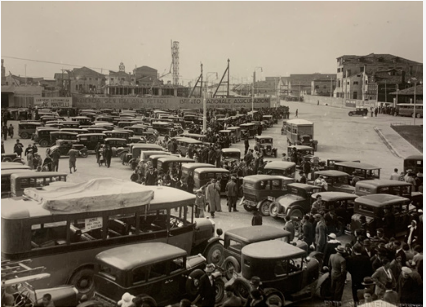
fig.191 Piazzale Roma congestionato, dopo l'apertura al traffico del 25 aprile 1933. sullo sfondo, il cantiere dell'autorimessa comunale. AP IUAV, Miozzi 2.fot/97
