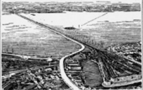
Il ponte del Littorio, voluta dal Duce, è oggi compiuta. Oggi, nel nome di San Marco, si inaugura il ponte sulla laguna.
