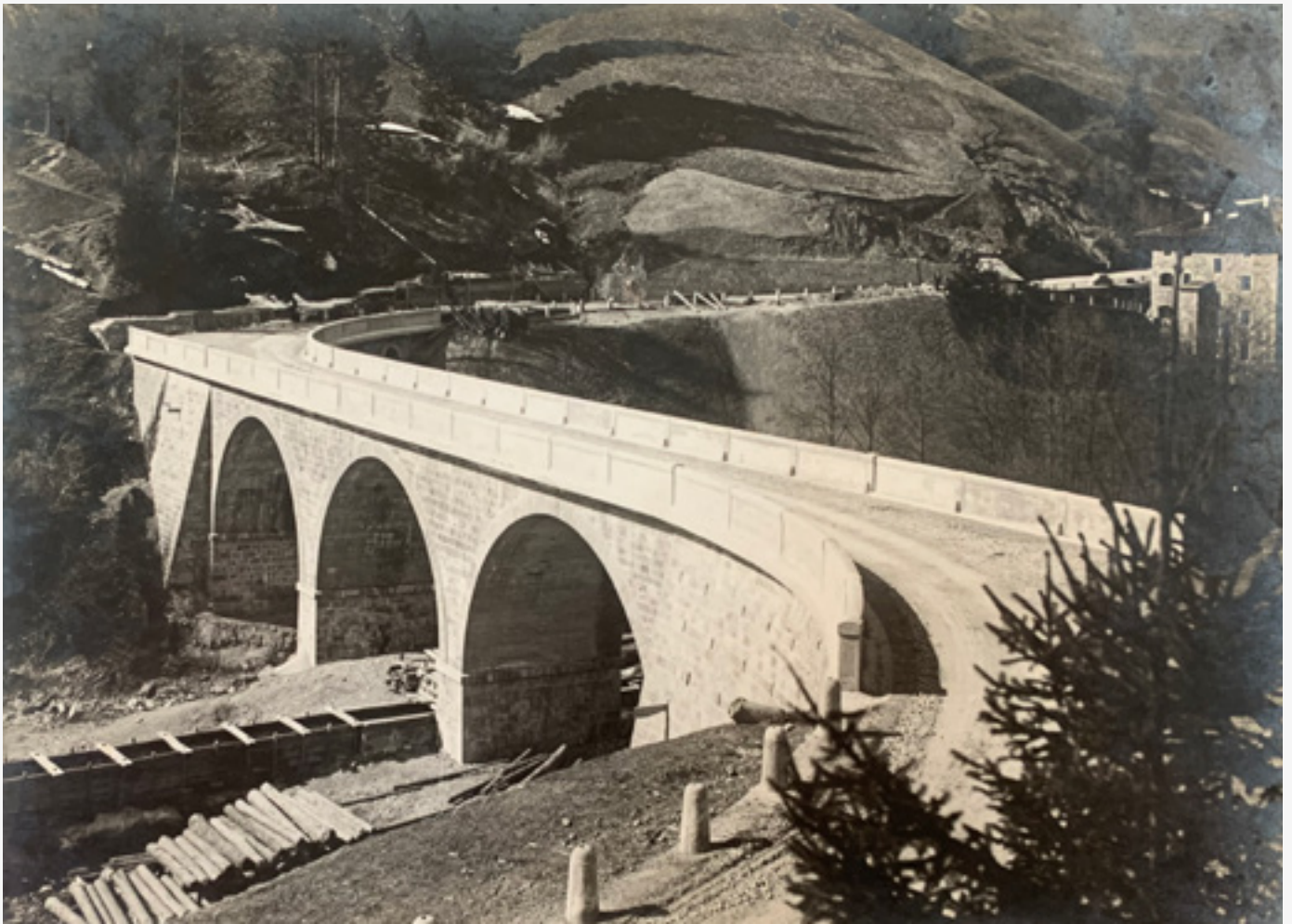
fig.30 Ponte sul Digon, AP IUAV Miozzi 2.fot/15
