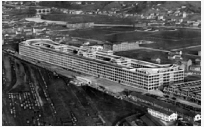
fig.211 Fotografia aerea del Lingotto di Torino, per confrontarne la linearità del prospetto con la seconda ipotesi del comune per l'autori- messa di Piazzale Roma
