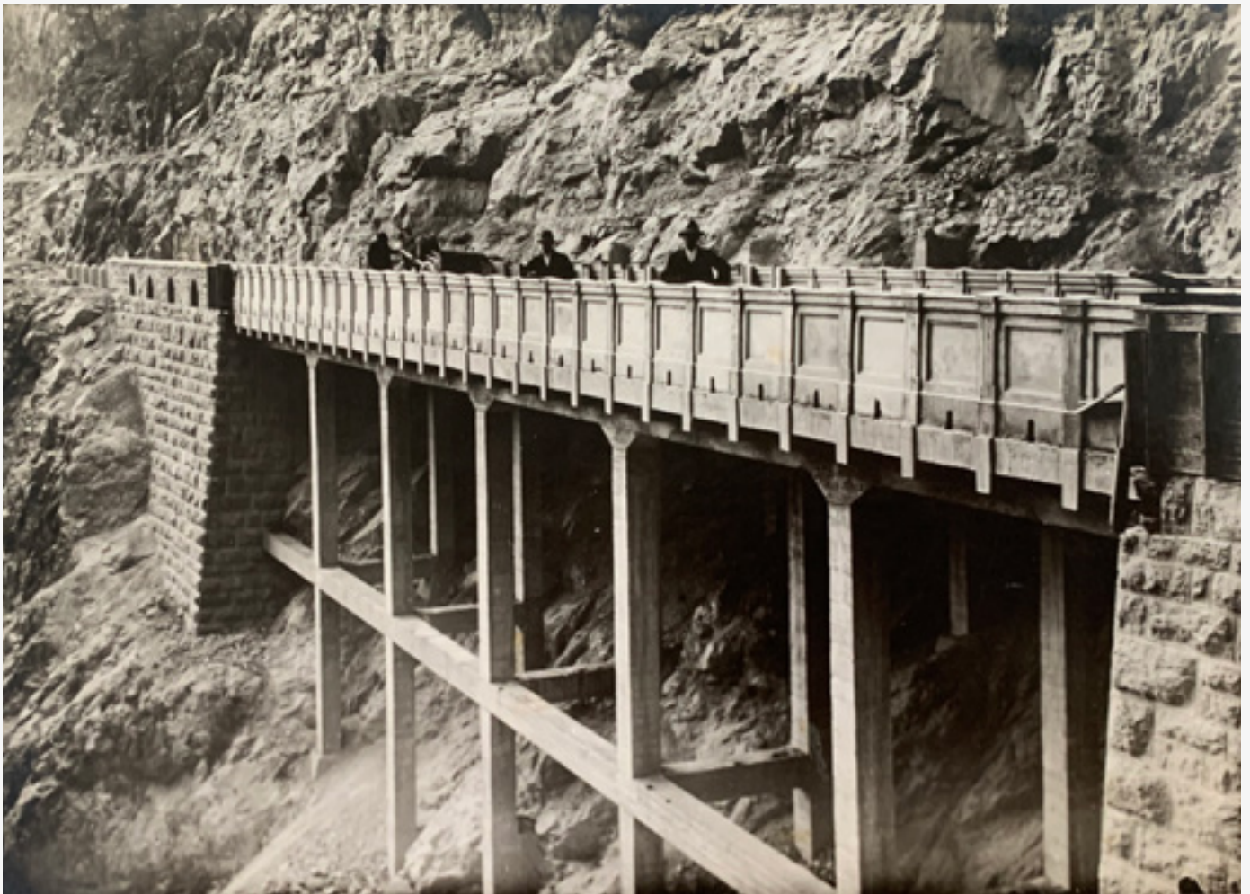
fig.32 Viadotto della Vessolo, Miozzi 2.fot/15
