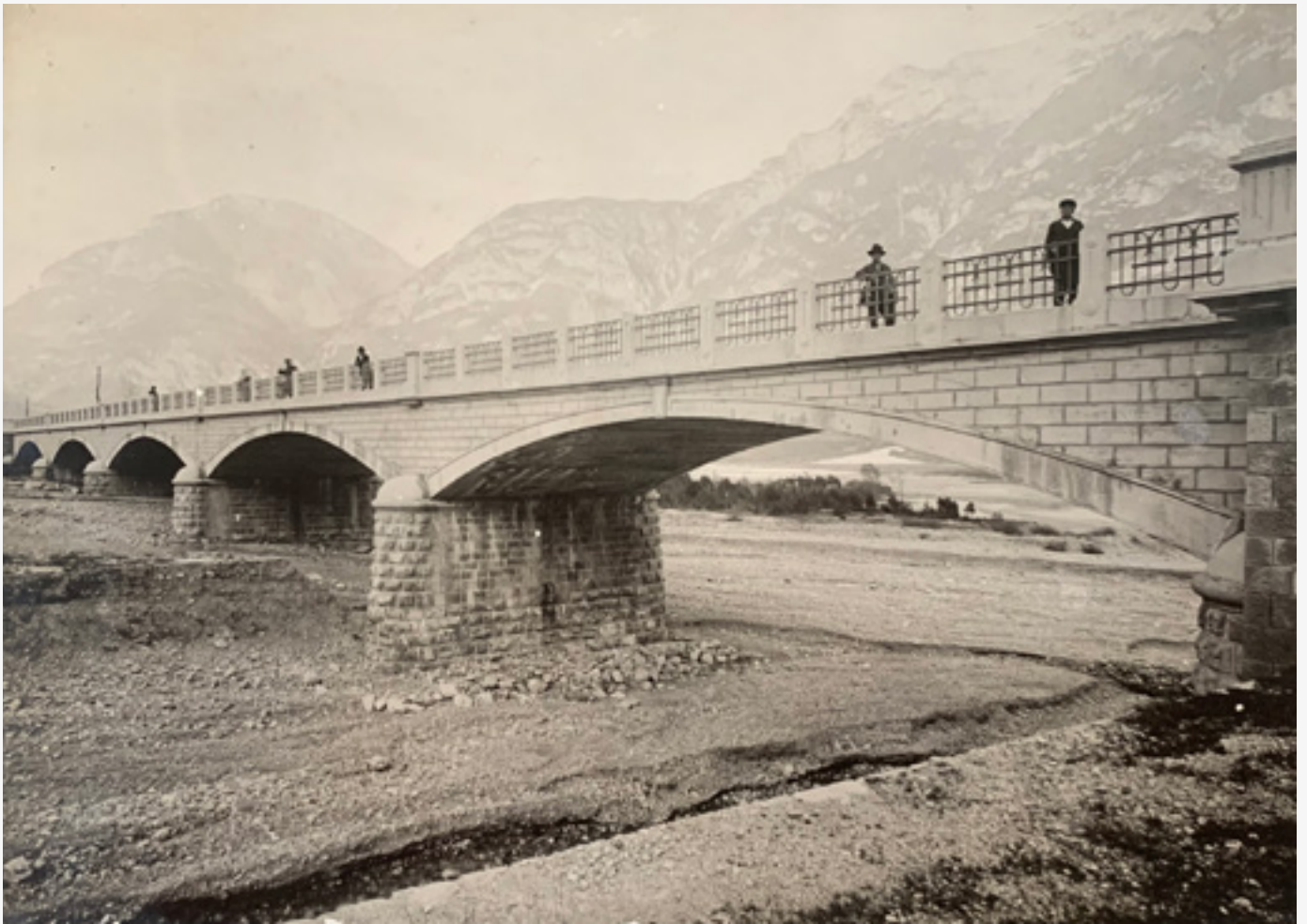
fig.40 Ponte sul Desedan, Miozzi 2.fot/15
