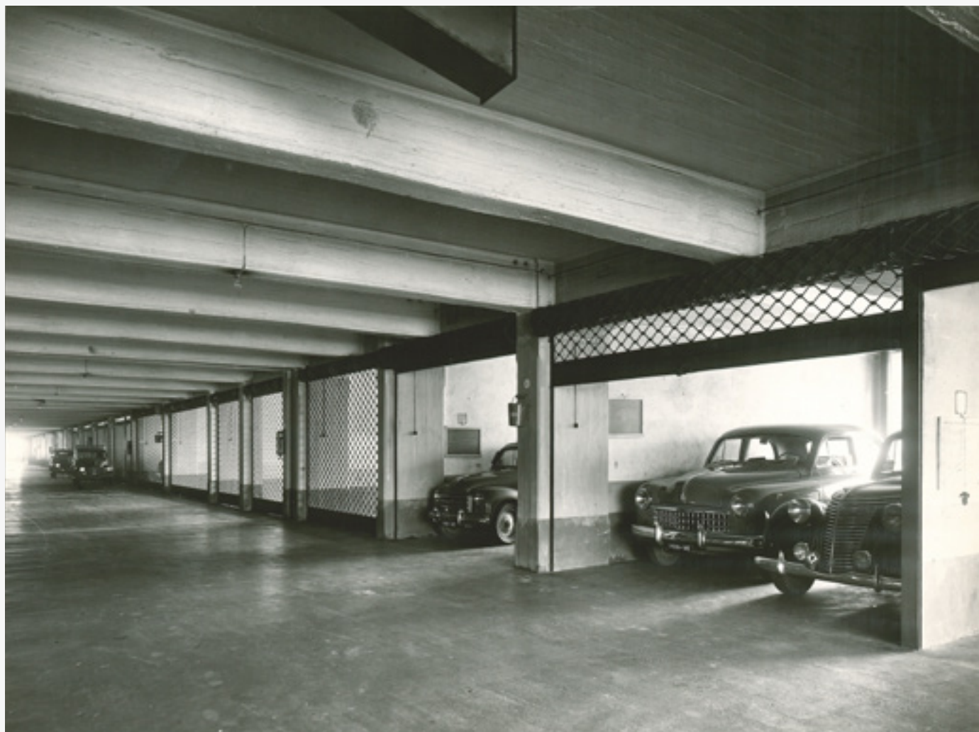
fig.220 Autorimessa comunale, interno di uno dei piani adibiti a box auto. Archivio storico impresa SACAIM, fasc. 00184
