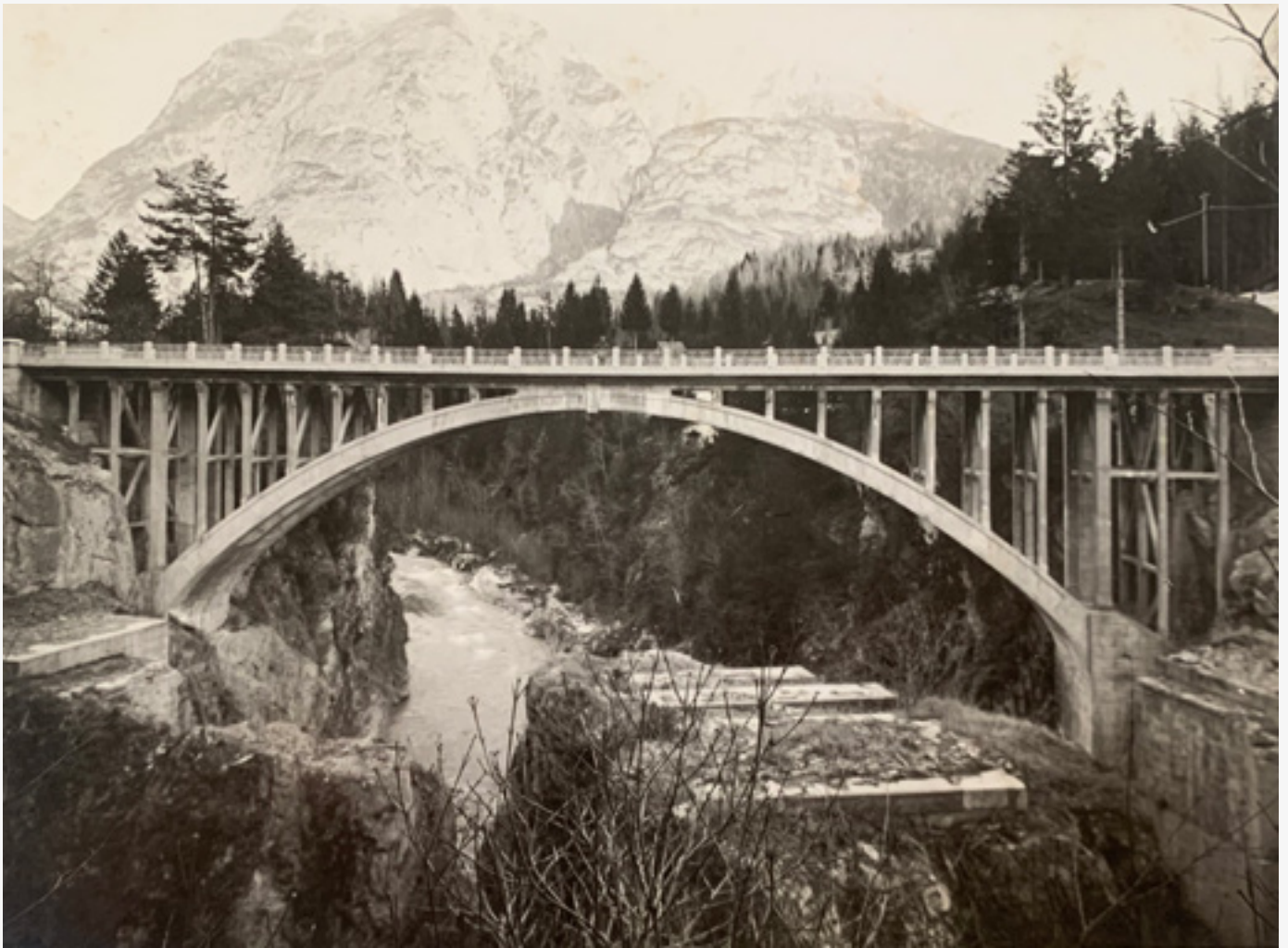
fig.34 Ponte di Gogna, veduta generale, Miozzi 2.fot/15
