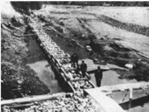
fig.62 Brevetto Miozzi-Andreocci, cantiere sul fiume Adige, in DALLA VALLE 1933
