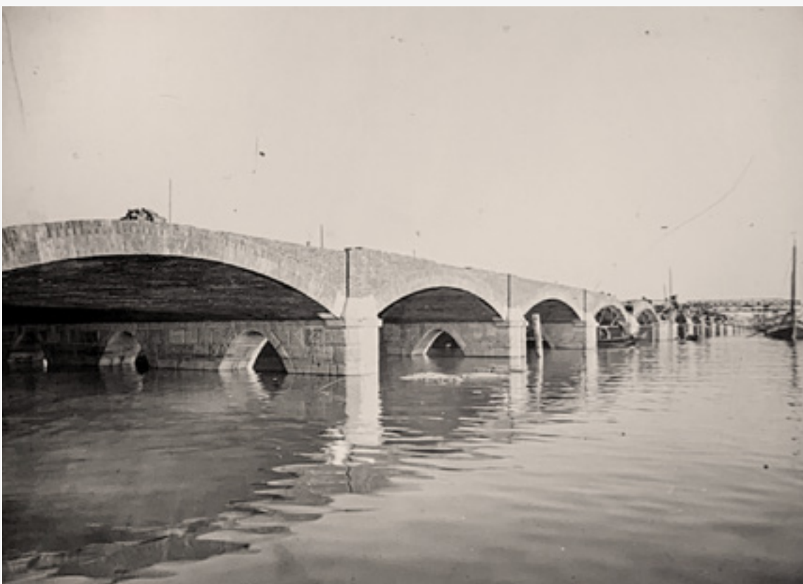
fig.192 Lastra fotografica Giacomelli con il cantiere del ponte al 1 febbraio 1932. Si vedono in opera le volte in mattoni e le pile. AP IUAV, Miozzi 2.fot/42
