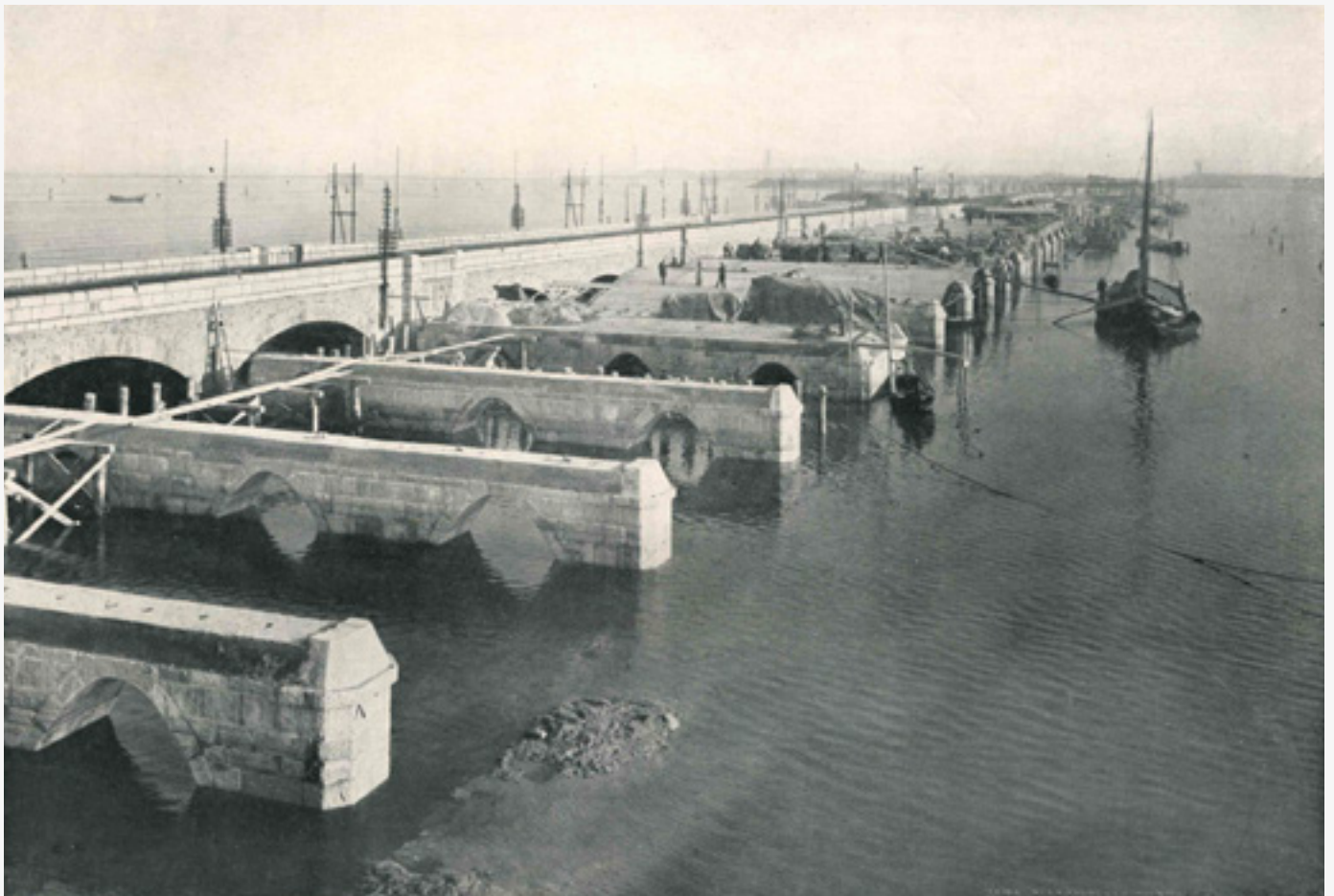
fig.180 Veduta del cantiere del ponte in costruzione. In evidenza, le pile in pietra d'Istria, con le tre aperture ad arco parabolico per garantire una maggior circolazione dell'acqua, in MIOZZI 1934, p.105
