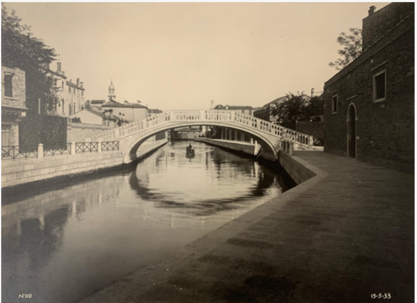
fig.197 Ponte della Sbiaca in una veduta del 15 maggio 1933. A destra, le proprietà, demolite negli anni Cinquanta, per la costruzione degli uffici SADE. Si vede la sistemazione definitiva delle fondamenta del Rio Novo e l'assetto più rialzato del profilo dell'arco, sempre policentrico, rispetto al ponte del Prefetto (cfr. fig. 195). AP IUAV Miozzi 2.fot/61.
