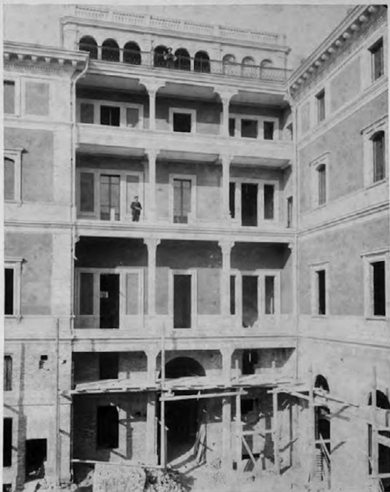
Prospetto verso la Montagnola Veranda in cemento armato in costruzione
