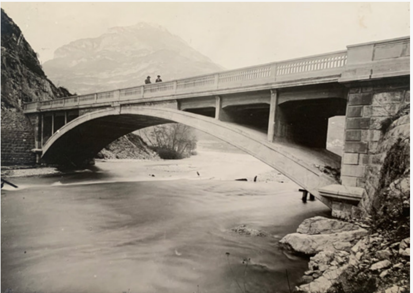
fig.41 Ponte sul Maé, Miozzi 2.fot/15
