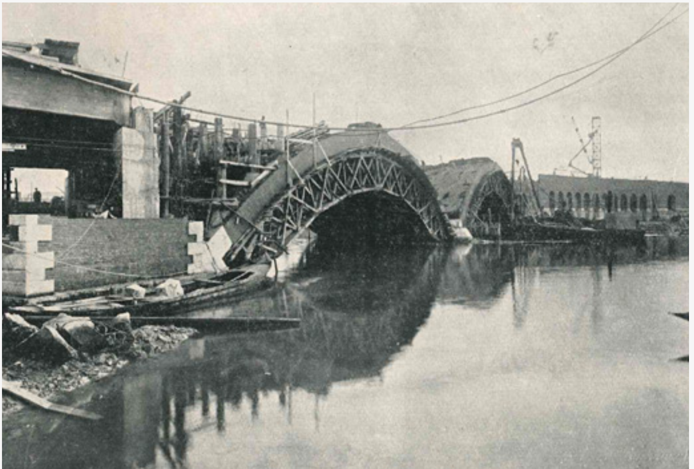
fig.177 Fotografia del ponte a doppia arcata sul Canal Grande. Dettaglio delle volte oblique in mattoni in costruzione e della struttura delle rampe di salita e di discesa in cemento armato rivestito in laterizio. Impresa esecutrice dei lavori, SACAIM, Venezia. In MIOZZI 1934, p.229
